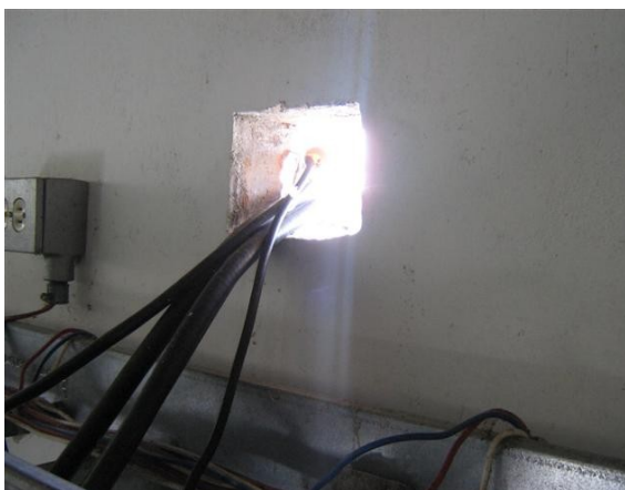
Recorrido de cables pasa muro
