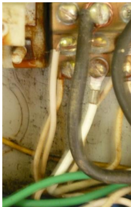
Oxido en tablero de breakers
