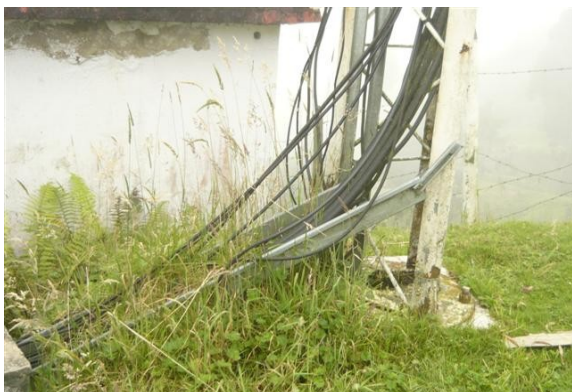
Escalerilla horizontal y base de la torre
