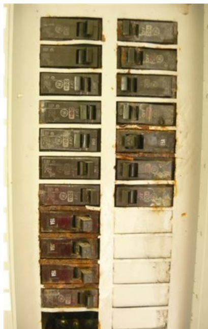
Caja de Breakers con goteo de agua
