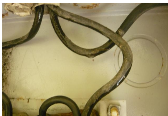
Goteo en tablero de Breakers
