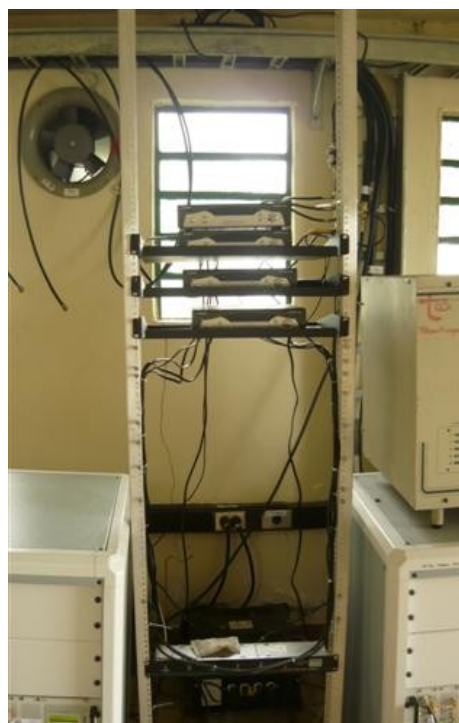
Rack de los receptores satelitales
