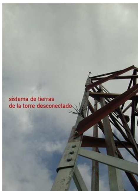
Sistema de tierra desconectado
