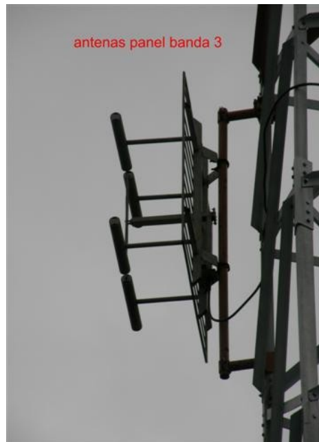
Antena tipo panel
