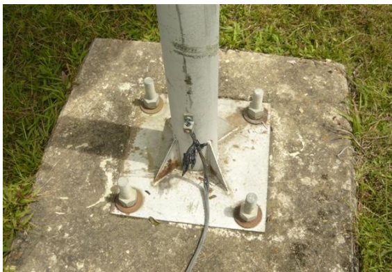
Sistema de tierra en antena satelital
