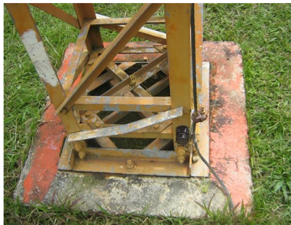
Sistema de puesta a tierra de Torre
