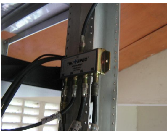
splitter sistema satelital
