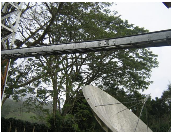
Escalerilla horizontal torre a salon de equipos
