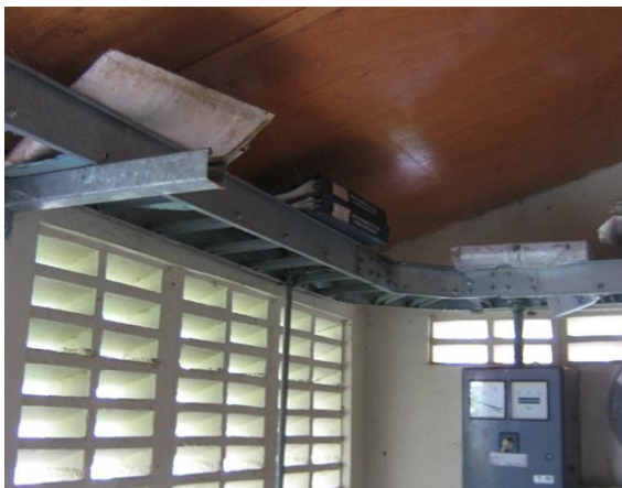
Escalerilla horizontal salón equipos
