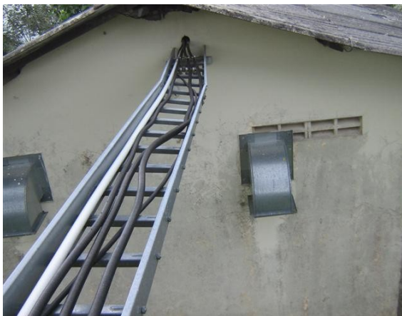
Recorrido de cables y escalerilla horizontal
