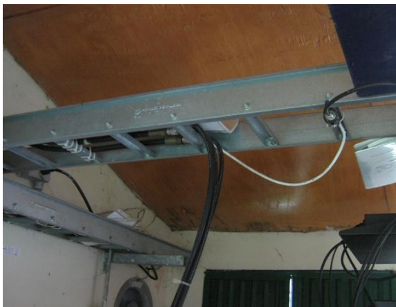
Escalerilla interna salón de equipos
