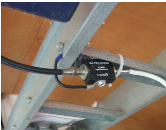
Protección descarga sistema satelital
