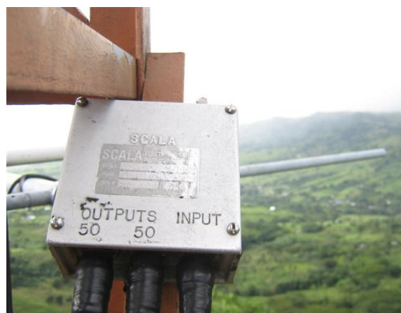
Distribuidor antenas
