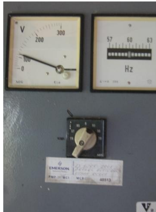
Medida voltaje y frecuencia
