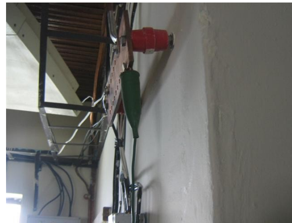
Sonda teluometro referencia tierra salón de equipos
