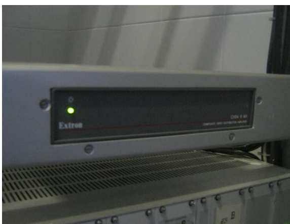
Distribuidor de video Extron
