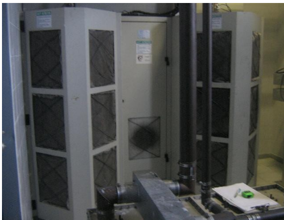
Filtros sistema de ventilación 2
