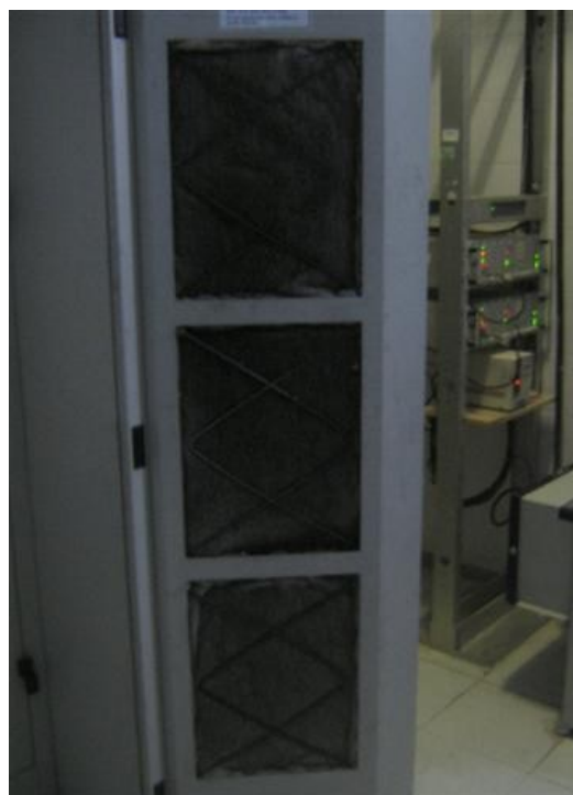
Filtros sistema de ventilación 1
