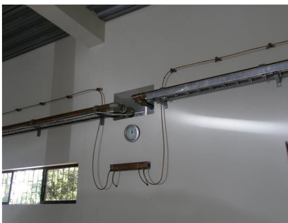
Escalerilla y sistema de tierra interior salón de equipos
