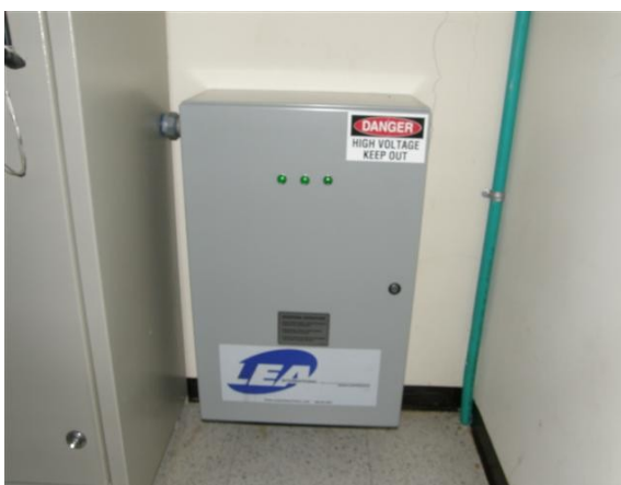
Protector de transientes salón de equipos
