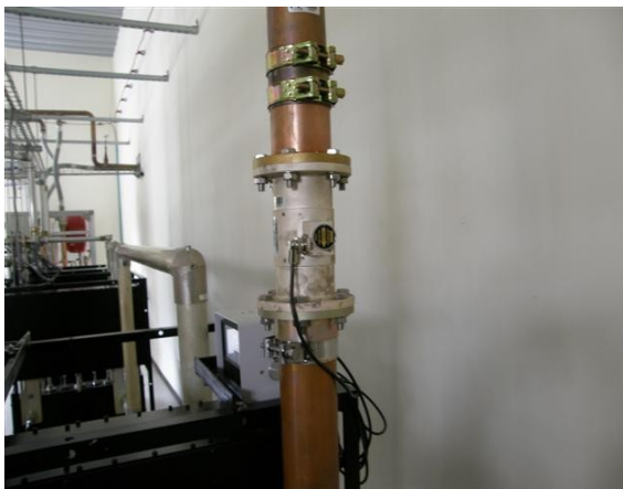
Transmisor y su multiplexor triline
