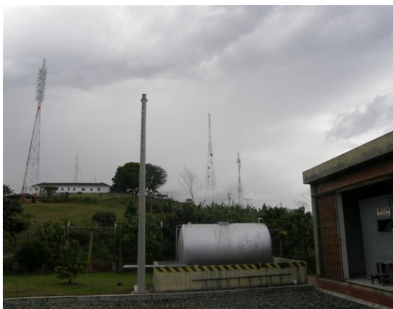
Tanque de combustible del generador
