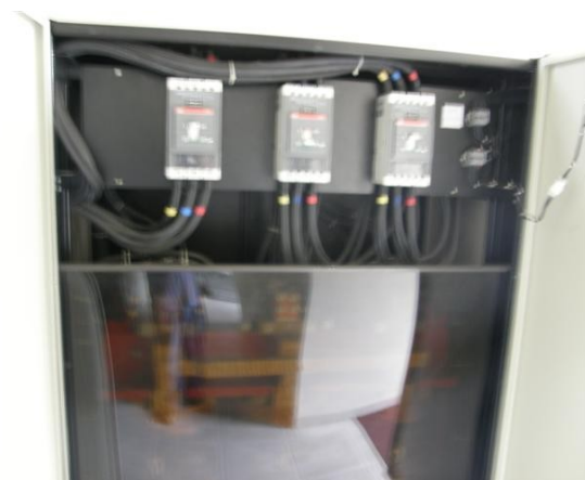
Rack de totalizador principal medición especial con protección de seguridad alta corriente
