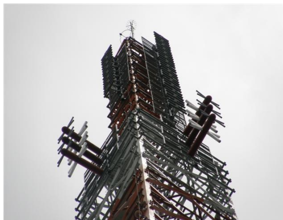
Arriba antenas T.V. Abajo Antenas F.M.
