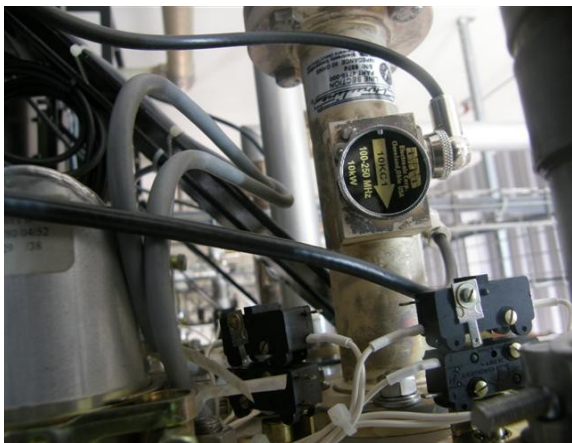
Diodo detector de potencia de transmisión de tv y truneline
