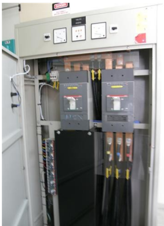
rack principal de energía no de puede medir I con pinza sencilla
