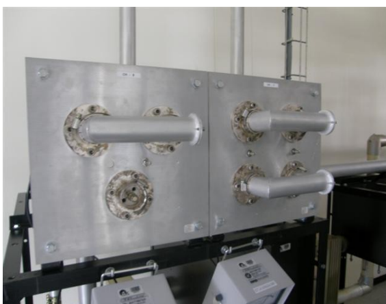
Conmutador de antena artificial de transmisión
