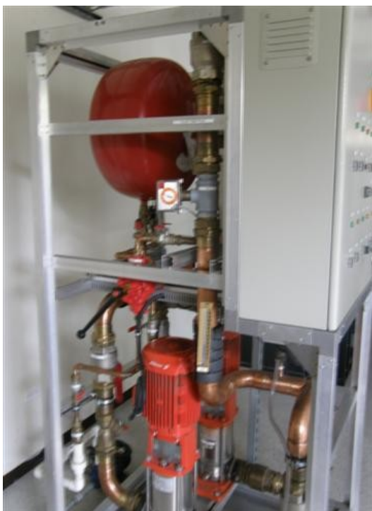
Moto bomba de agua para los transmisores
