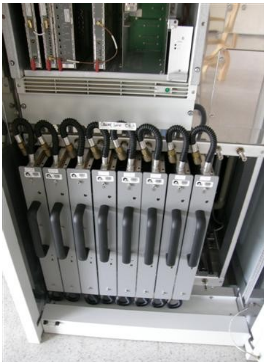
Transmisor con driver y amplificadores
