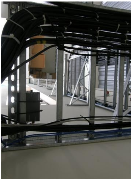
Escalerilla interna salón de equipos
