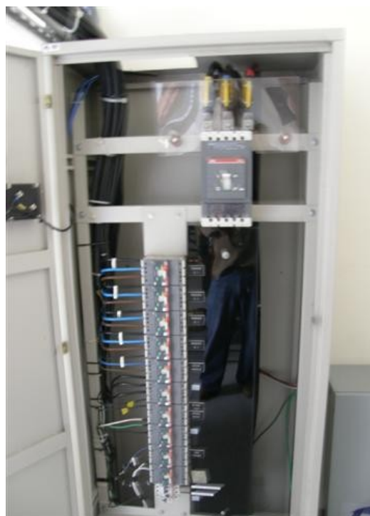
Rack de breaker para cada transmisor en el salón de equipos
