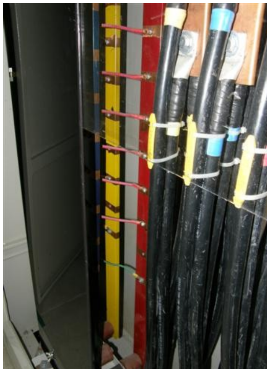
Cables totalizador principal
