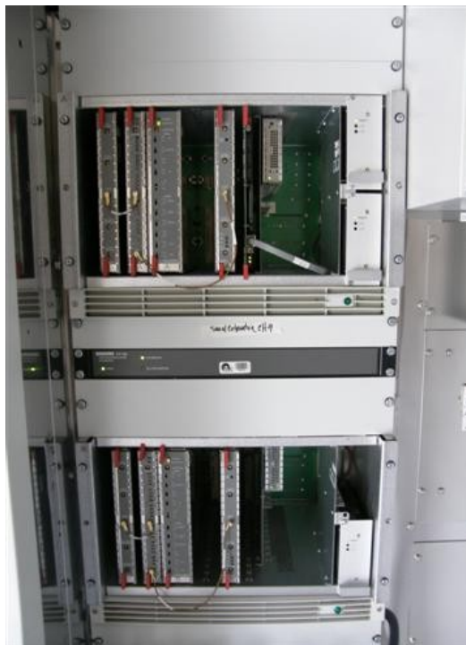
Transmisor con driver y amplificadores
