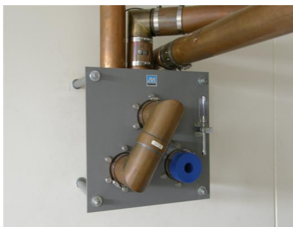
Conmutador manual de radio F.M.
