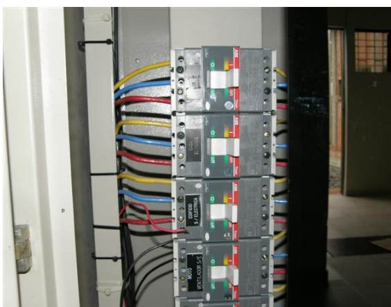
Breaker en tablero de energía para alojamiento y salón equipos
