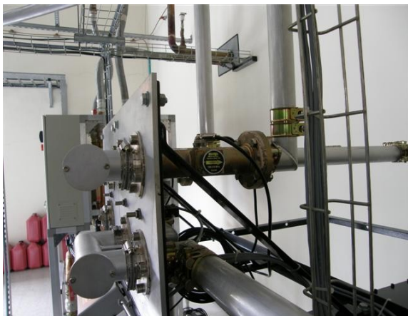
Transmisor y su multiplexor triline
