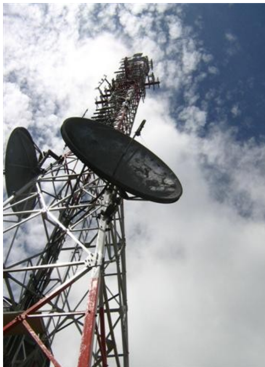
Vista de Antenas de Microondas Fig.1
