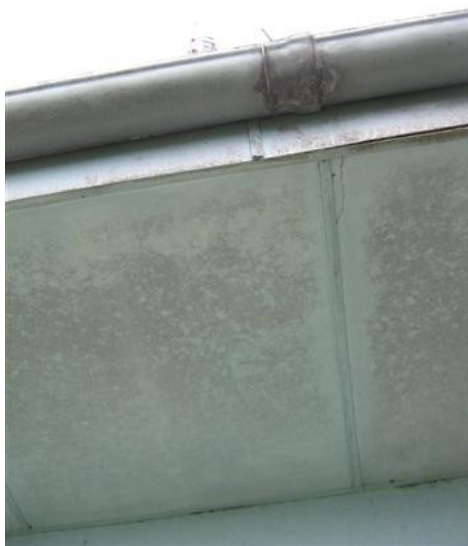
Canal con filtracion de agua
