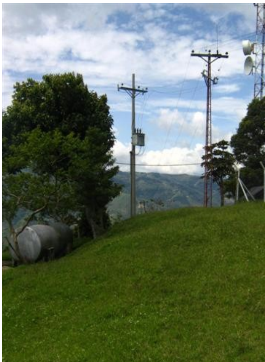
Transformador 50 KVA Fig.1
