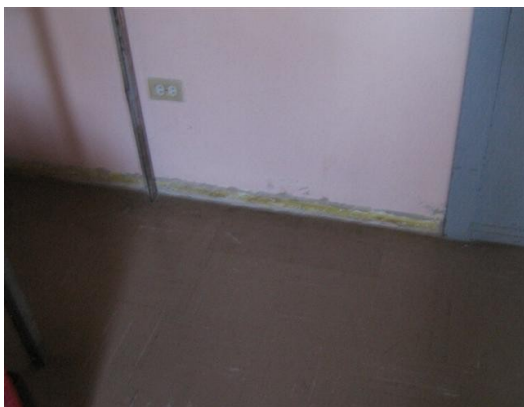
Guarda escoba en mal estado
