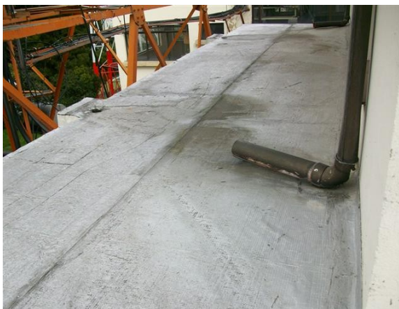
impermeabilizacion terraza occidental
