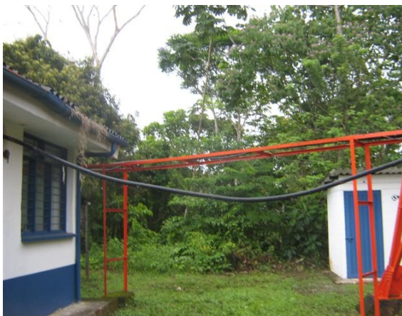
Escalerilla hacia el cuarto de equipos
