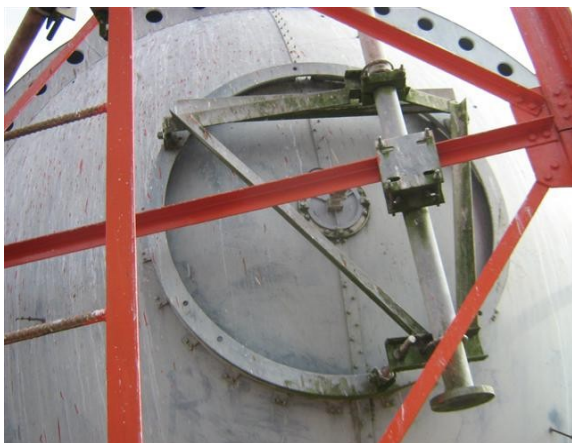
Antena microonda
