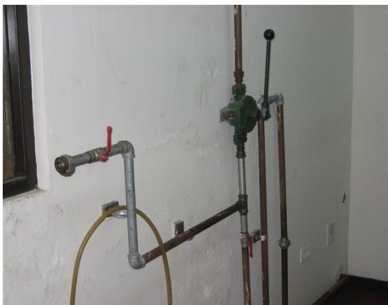
Motobomba y tubería de ACPM
