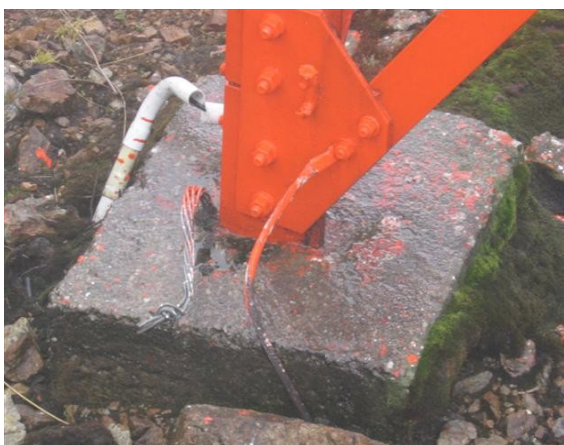
Conexión tierra torre en pata 1
