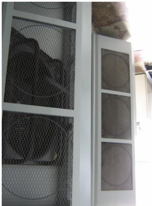
Extractor del transmisor Harris – Cadena Uno
