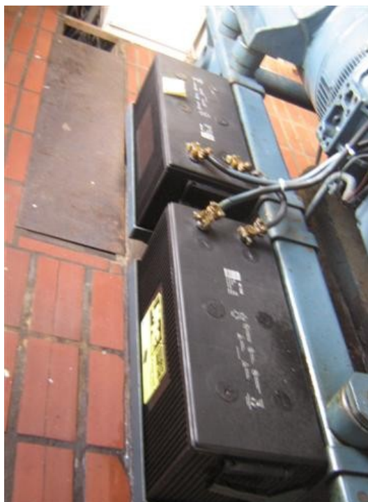
Baterías del generador principal
