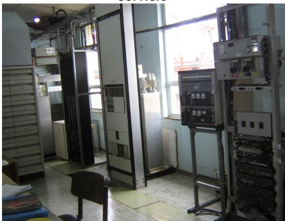
Sistema de microondas
