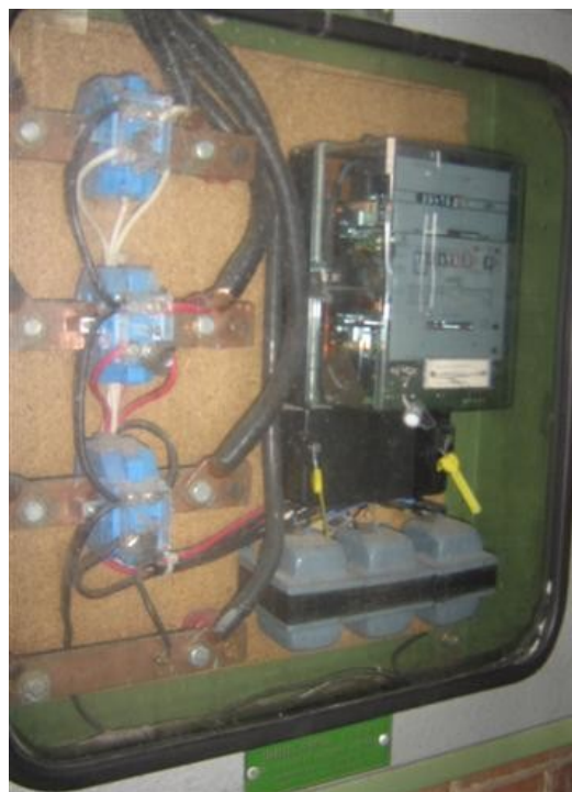
Contador potencia activa - reactiva
