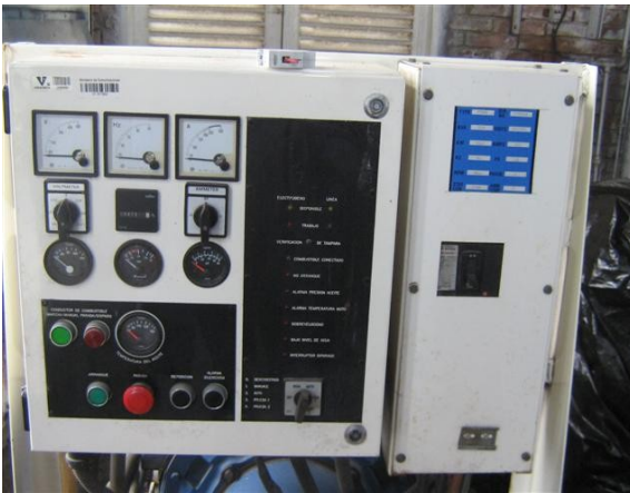
Placa y controles del generador de reserva
