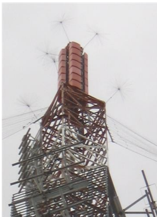
Antenas panel fuera de servicio transmisor
