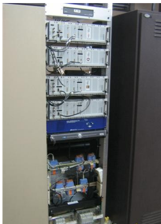
Rack de sistema de gestion y offset
