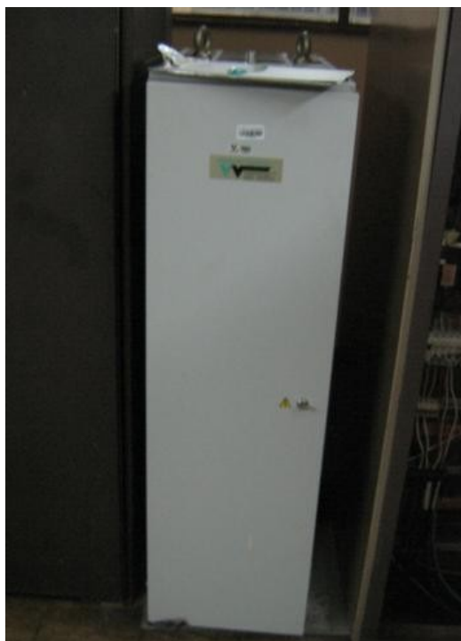
Transformador 10KVA
