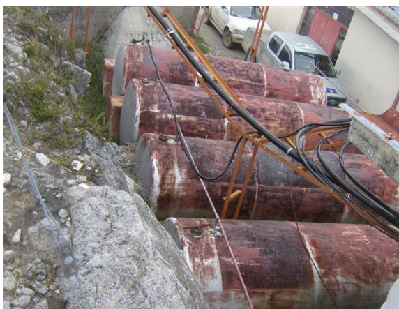
Estado tanques de combustible
