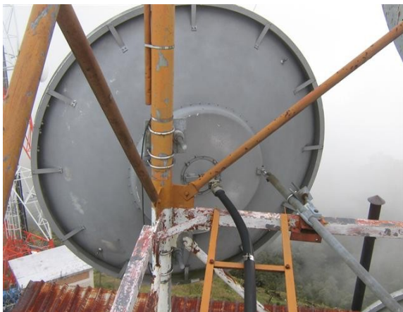
Antena microondas en torre 2
