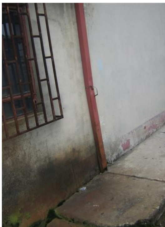
Humedad piso exterior a la edificación
