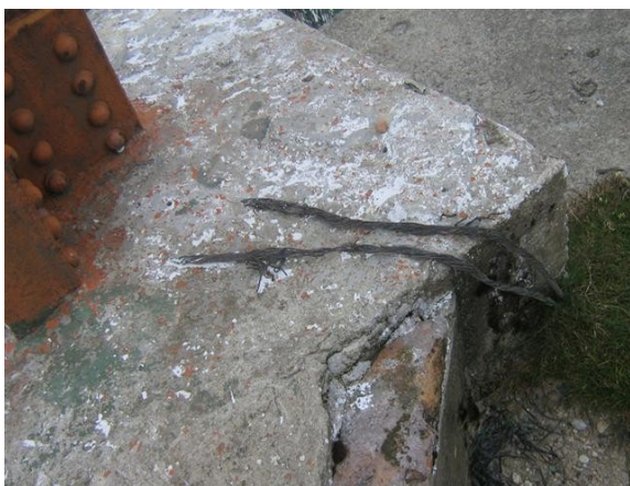
cable de tierra en mal estado
