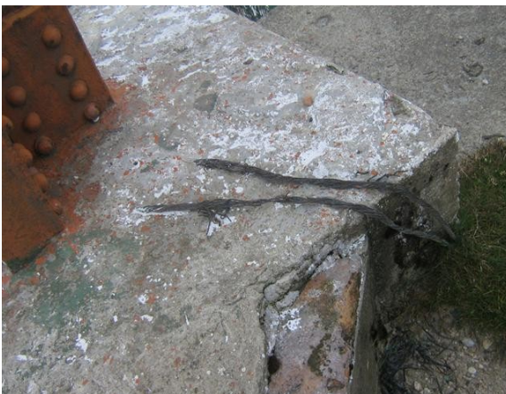
Sistema de puesta a tierra torre1
