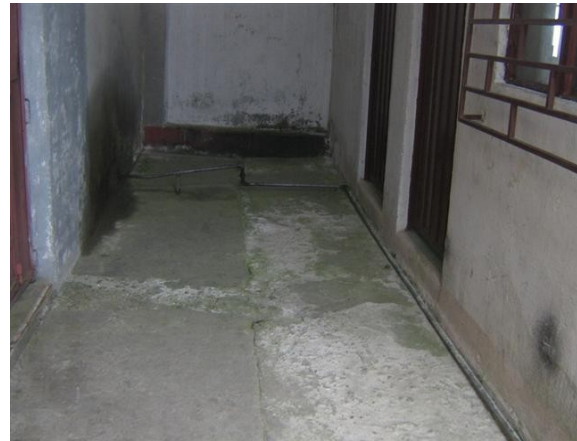
Rastros de humedad en la estación
