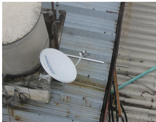
Antena satelital banda Ku
