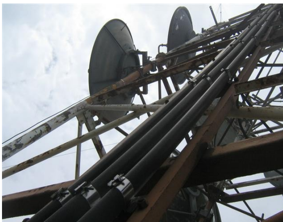
Antenas torre 2 y líneas de transmisión
