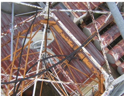
Corrosión existente en la torre
