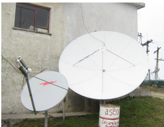
Antenas RTVC - gestión y banda C
