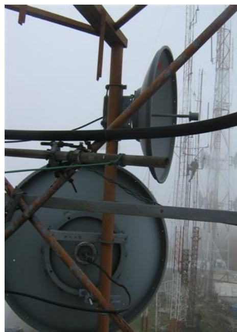
Antena microondas en torre 2
