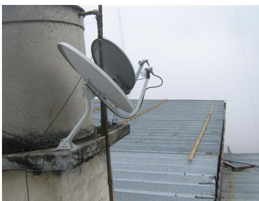
Antena satelital banda Ku
