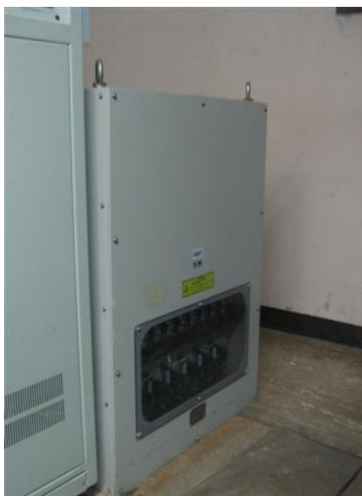
Transformador 40 KVA
