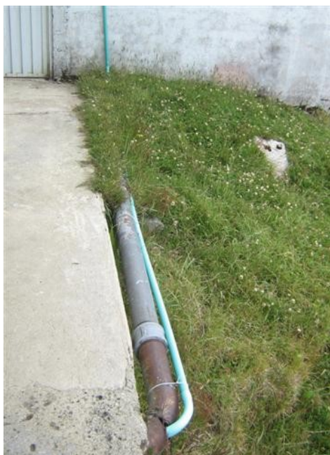
Acometida eléctrica salón de equipos
