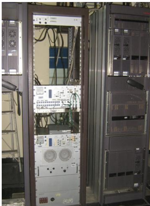
Panel de control y transferencia audio y video
