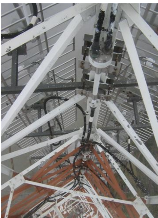
Distribuidor y latiguillos
