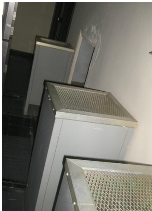
refrigeración carga fantasma Tx A.B.S
