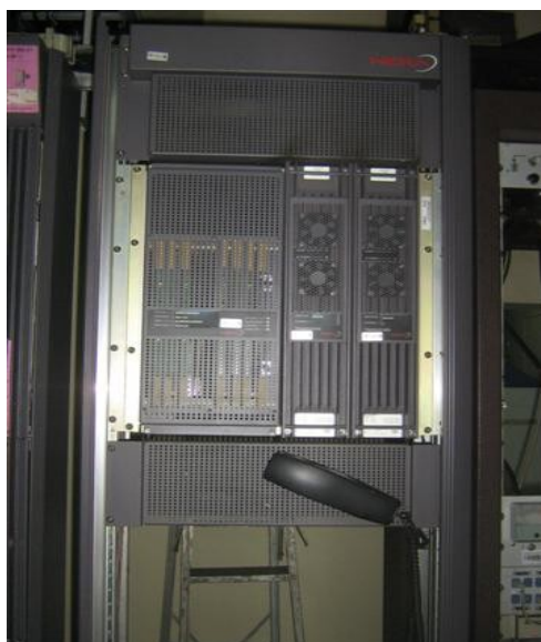
Fuente de transmisores Nera ETB
