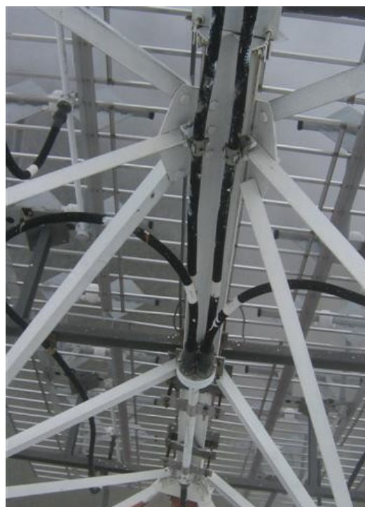
Distribuidor y latiguillos
