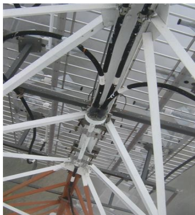
Distribuidor y latiguillos
