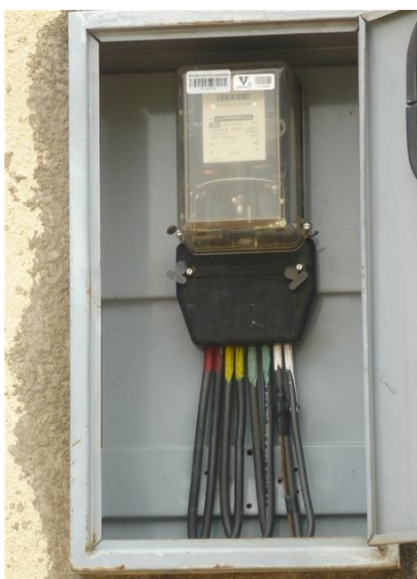
Medidor de energía
