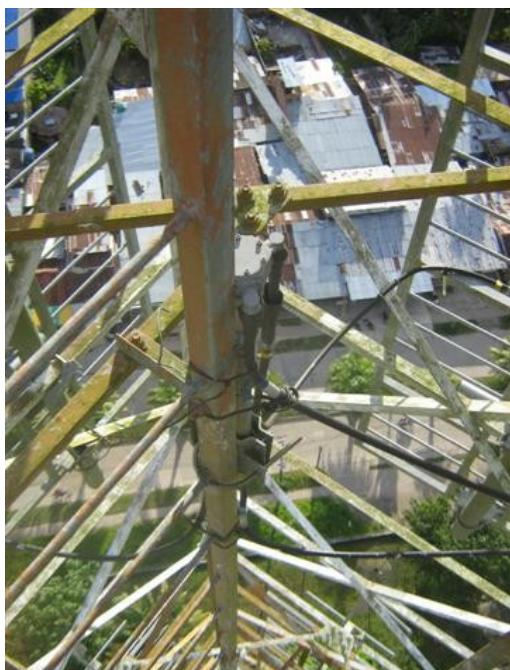
Distribuidor antenas
