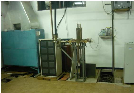
Conmutador de antenas señal Colombia
