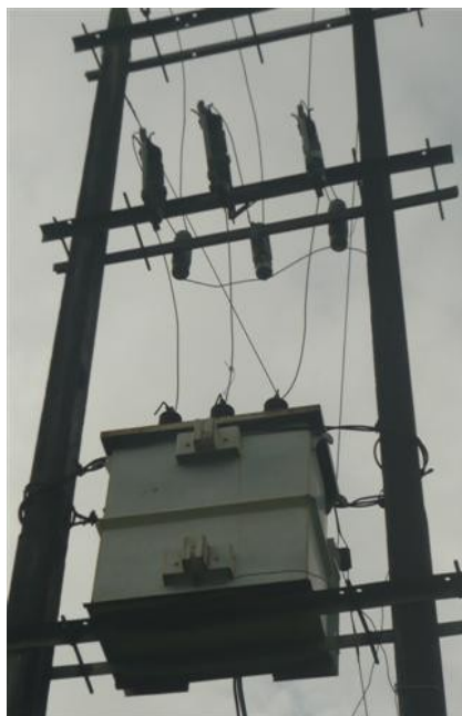
Acometida Eléctrica Transformador
