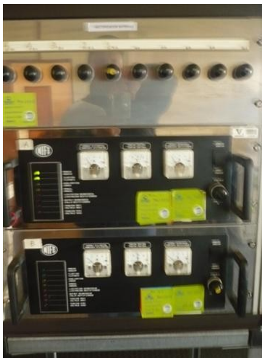
Rectificador de baterías
