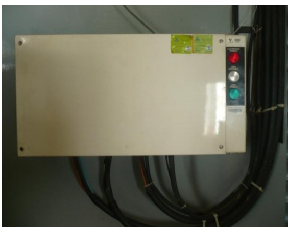
Transferencia red-planta fuera de servicio
