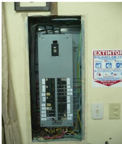
Vista del tablero de distribución
