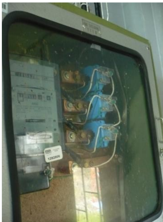
Contador general de la estación
