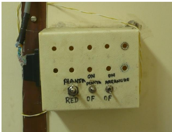
Caja de transferencia manual
