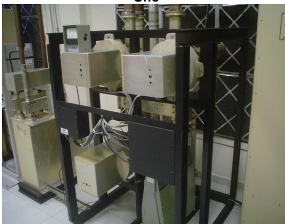
Combinador A+B Transmisor Principal Señal Institucional
