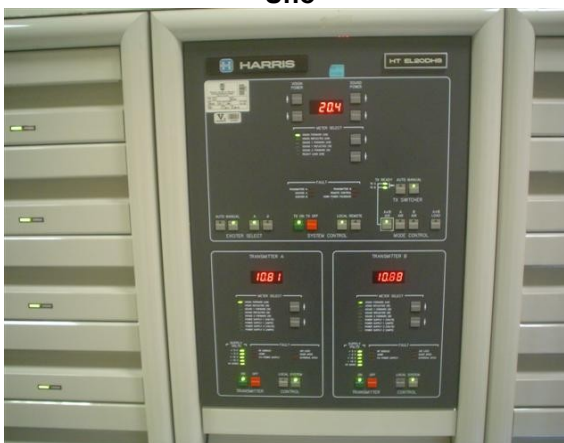
Panel Medidas Transmisor Principal Señal Institucional
