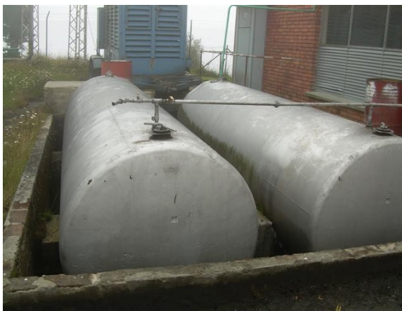
Tanques de Combustible
