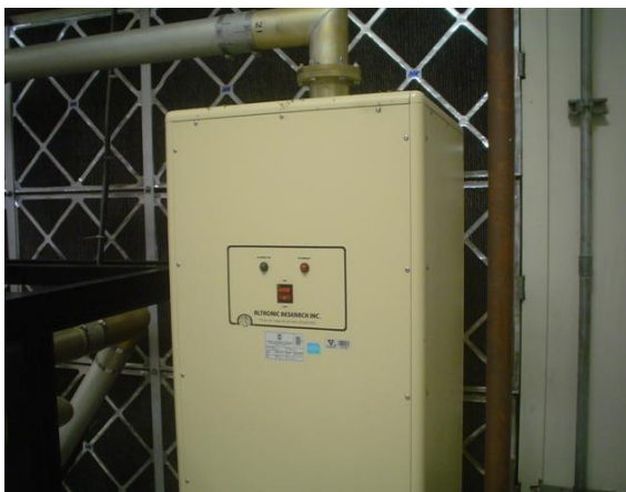
Carga Transmisor Principal Señal Institucional
