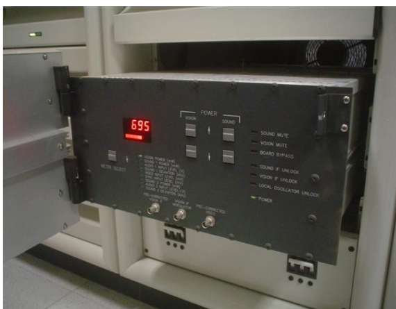
Excitador B Transmisor Principal Canal Uno
