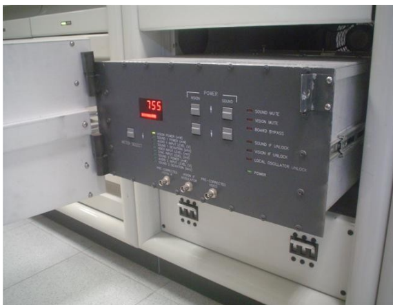
Excitador B Transmisor Principal Señal Institucional
