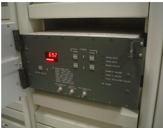
Excitador A Transmisor Principal Canal Uno
