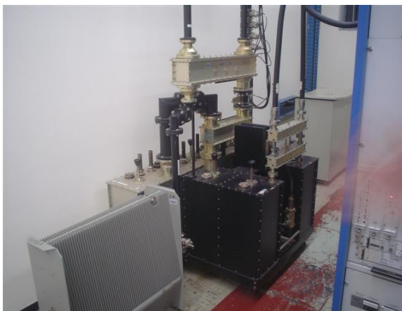
Combinador Transmisor Principal Señal Colombia
