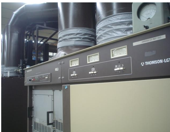
Panel Medidas Transmisor Reserva Canal Uno
