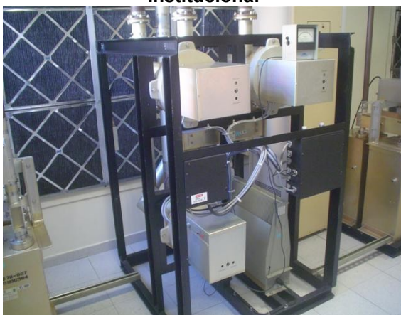
Combinador A+B Transmisor Principal Canal Uno
