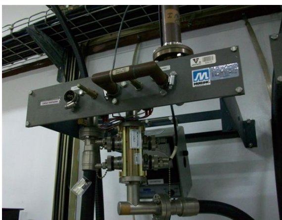
Conmutador transmisor thomcast canal 2
