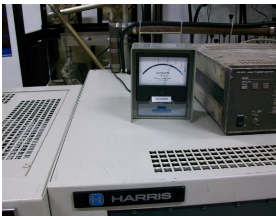
Medida potencia SC excitador A
