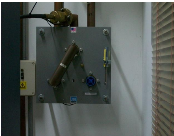
Conmutador Tx-Carga RN (radio nacional)
