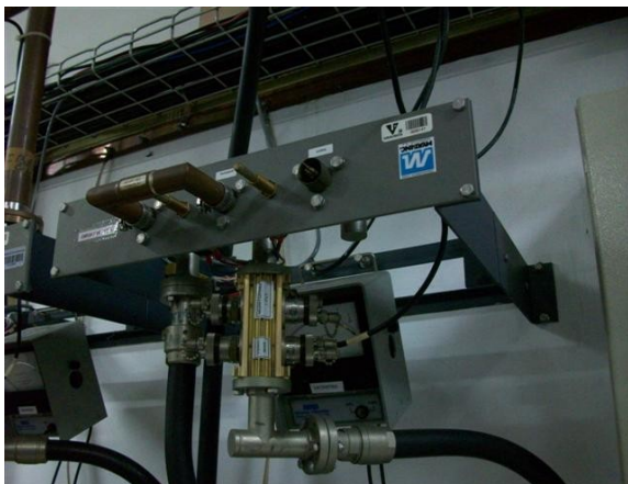
Conmutador transmisor thomcast canal 4
