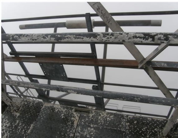
Detalle pintura y corrosión
