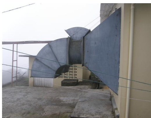
Ductos de ventilación
