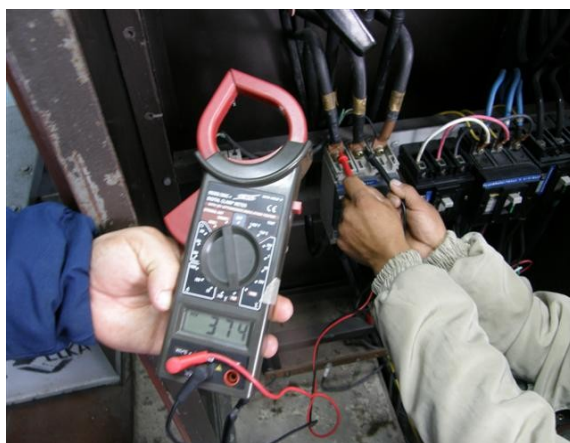
Medida voltaje R-S totalizador principal
