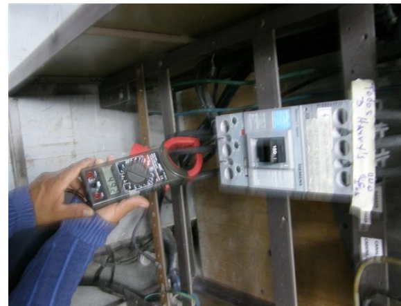
Consumo de corriente fase S transmisores Harris
