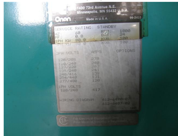
Especificaciones planta eléctrica
