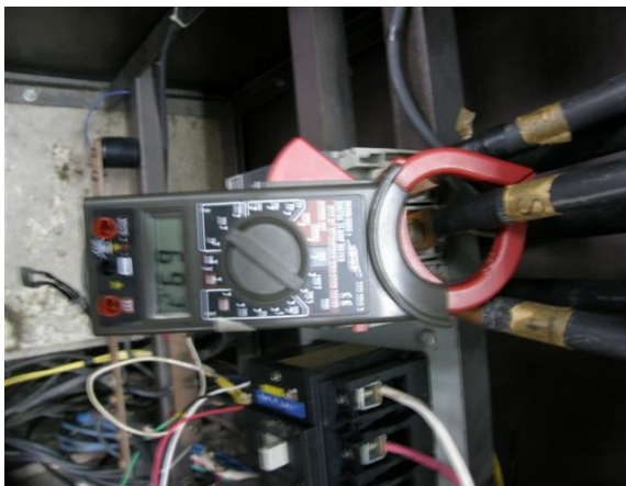
Corriente fase S totalizador principal
