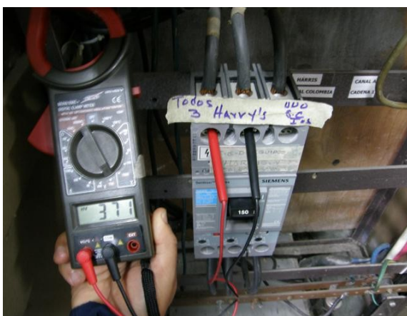
Voltaje R-S transmisores Harris
