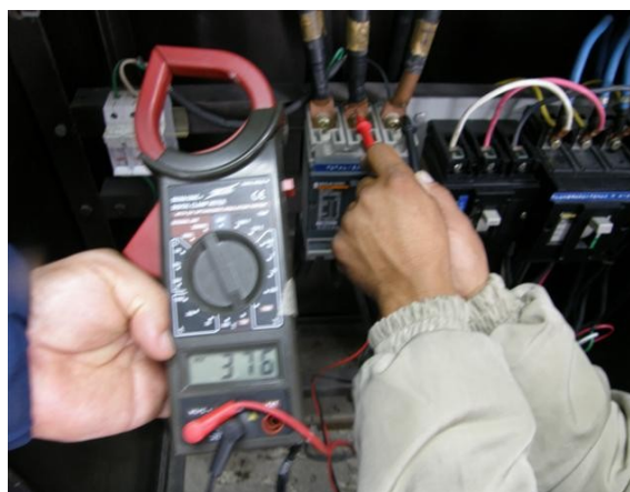
Medida voltaje R-T totalizador principal
