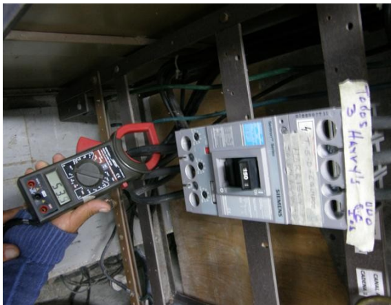
Consumo de corriente fase R transmisores Harris
