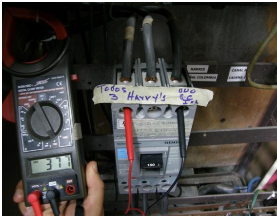
Voltaje R-T transmisores Harris
