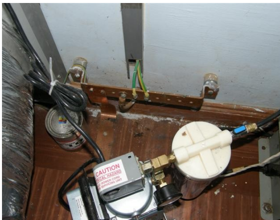
Puesta a tierra salón de equipos
