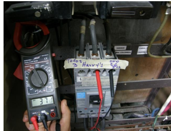
Voltaje S-T transmisores Harris
