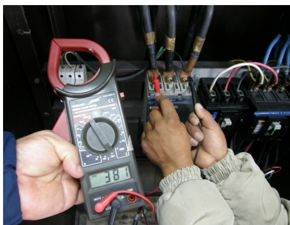
Medida voltaje S-T totalizador principal
