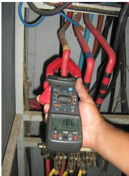
Medición Corriente fase R'
