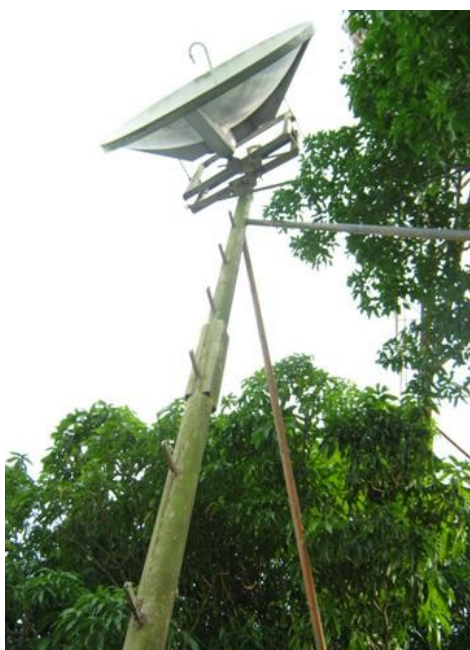
Antena microondas Telecaribe Fuera de servicio
