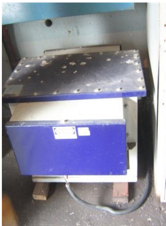
Transformador 50 Kva Telecaribe
