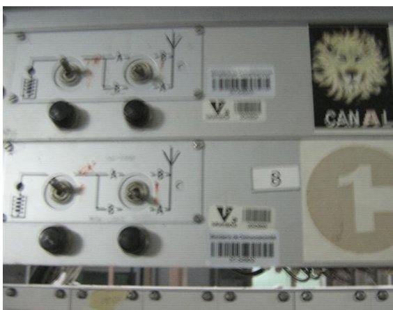
transferencias automáticas equipos Harris
