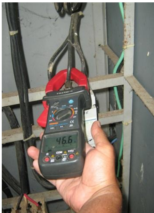
Medición Corriente telecaribe fase S'
