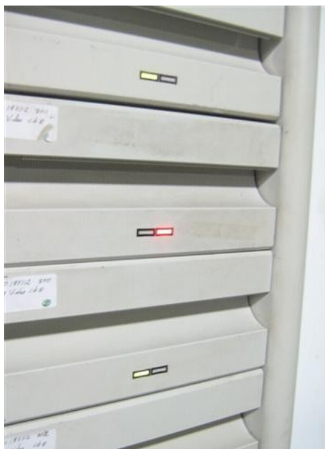
Amplificador alarmado Canal Institucional
