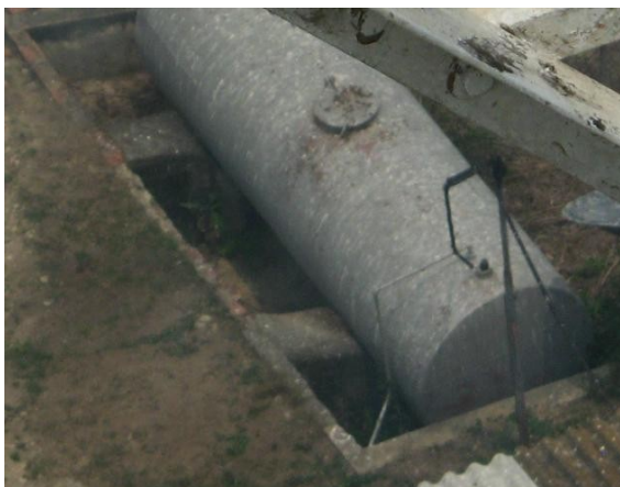
Tanque de almacenamiento de combustible
