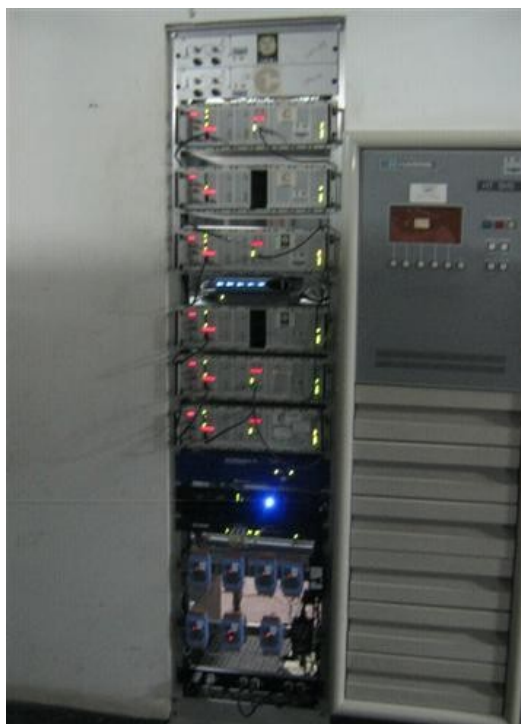
Rack sistema de gestión y Offset de Precisión
