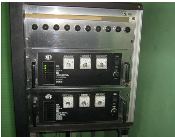
Rectificador - Cargador
