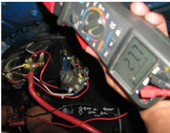
Medición batería planta CUMMINS
