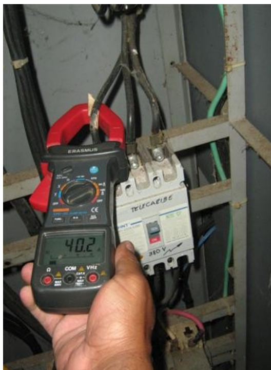
Medición Corriente telecaribe fase R'
