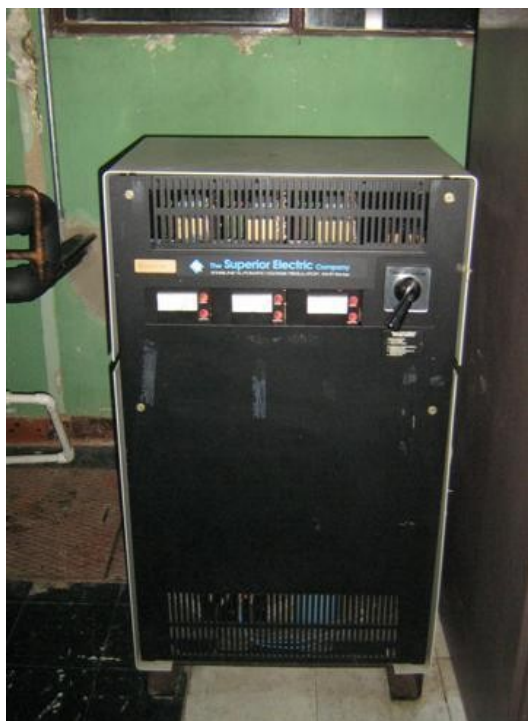
Regulador - Estabilizador de voltaje
