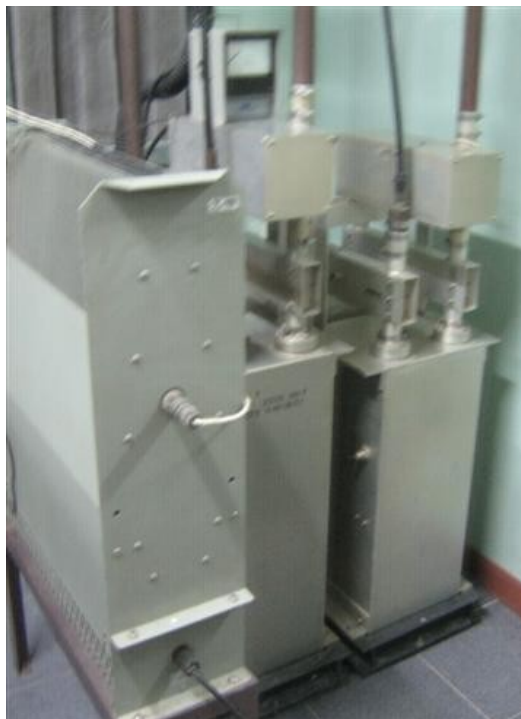
Cadena de filtros Tx Harris Canal Uno
