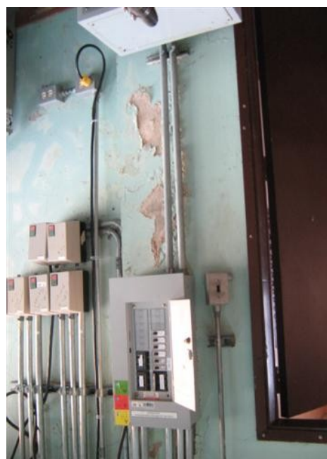
Caja de Breakers y Pintura Salón de equipos
