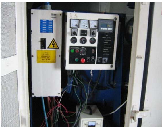
Panel de control planta CUMMINS
