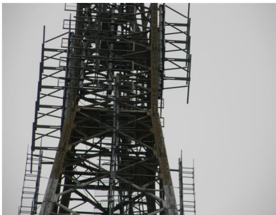
Antenas parte superior de la torre
