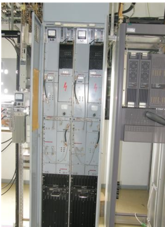
Equipos microondas telefonquen fuera de servicio
