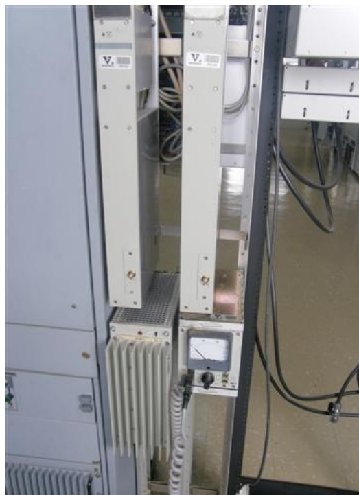
Equipos microondas fuera de servicio
