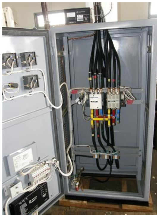
Caja de transferencia planta 2
