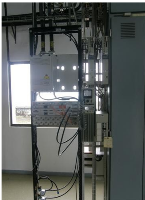
Equipos de microondas ETB
