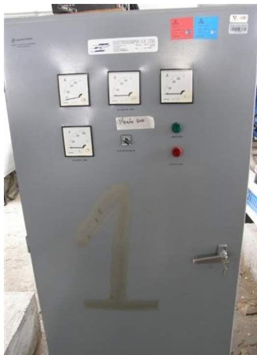
Caja de transferencia planta 1
