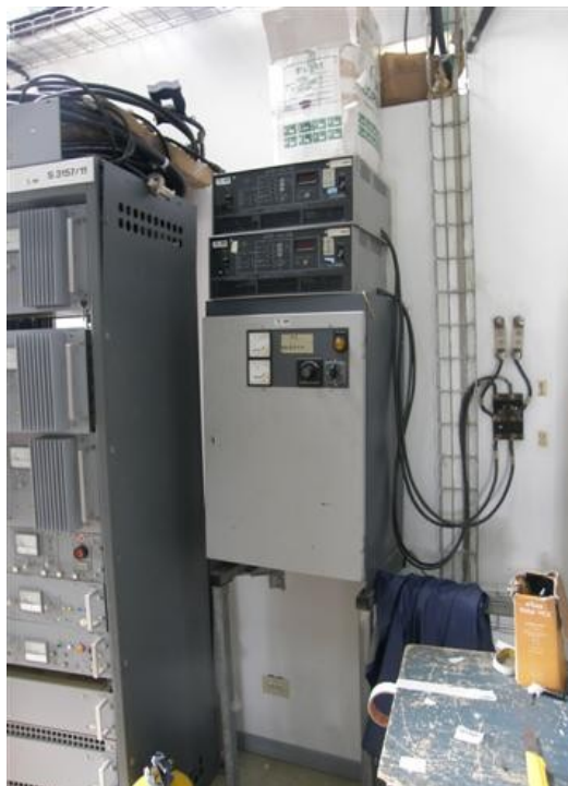
Cargador de baterías fuera de servicio
