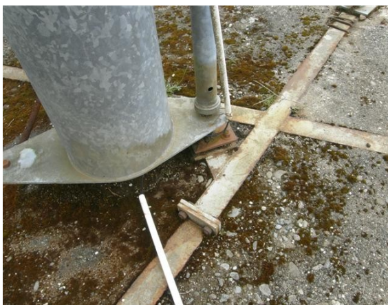
Base antena parabólica
