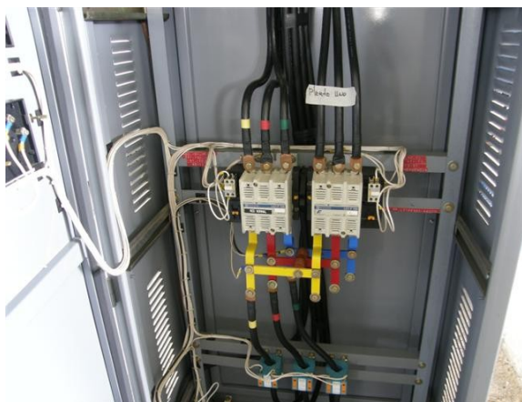
Caja de transferencia planta 1 por dentro
