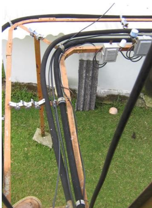
escalera horizontal y recorrido de cables
