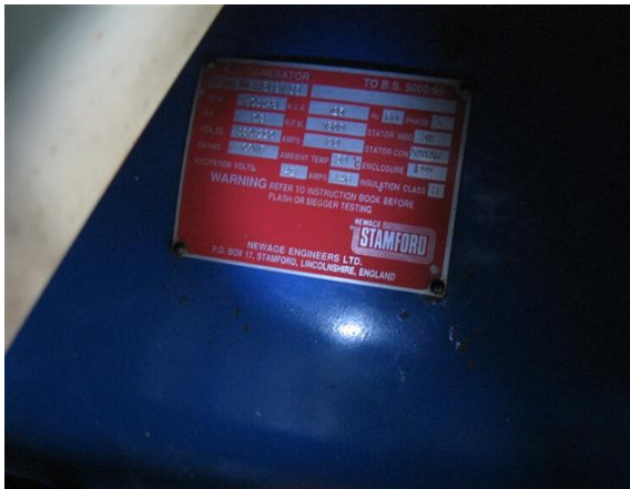
placa generador Stanford planta perkins
