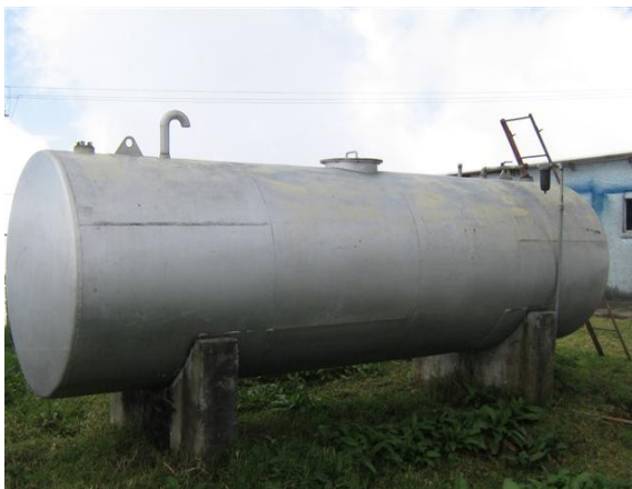
Tanque almacenamiento combustible
