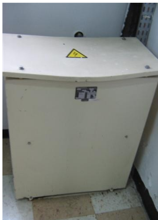
transformador de T.V andina fuera de servicio
