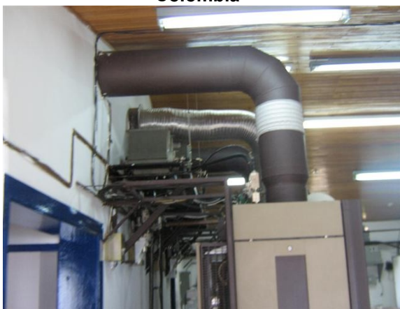
Ducto de refrigeración señal Colombia
