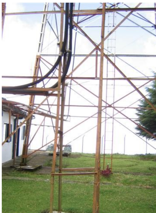
escalerilla vertical y recorrido de cables
