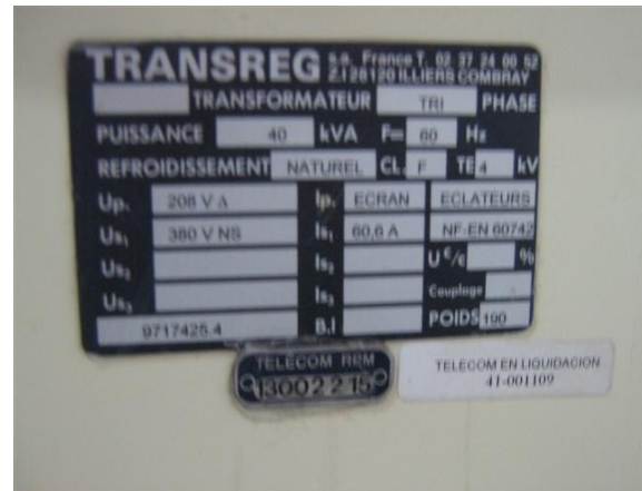
placa transformador de T.V andina Fuera de servicio
