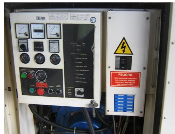
panel de control planta perkins
