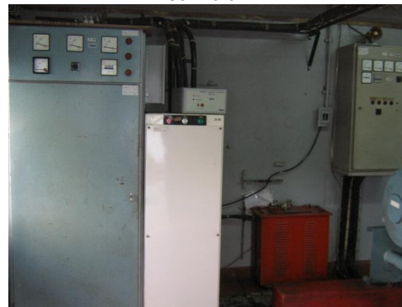
Totalizador y transferencia salón de plantas
