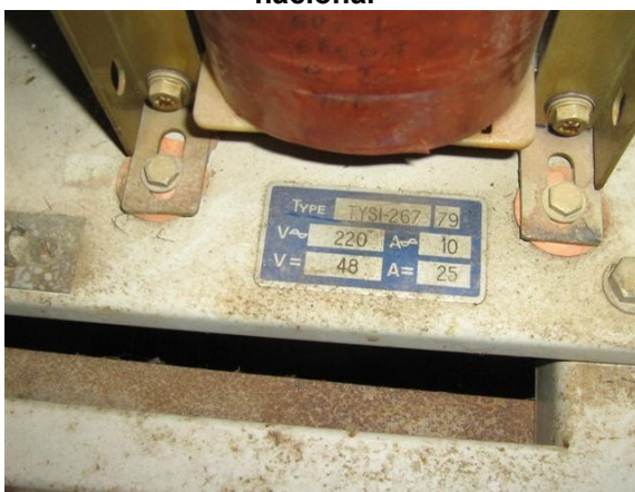
placa cargador de baterías fuera de servicio
