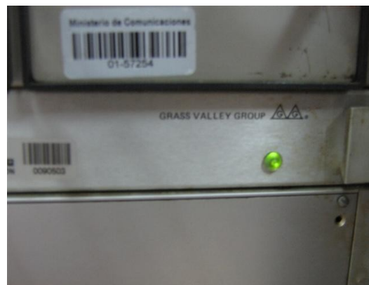
Distribuidor de video Tx principal SI
