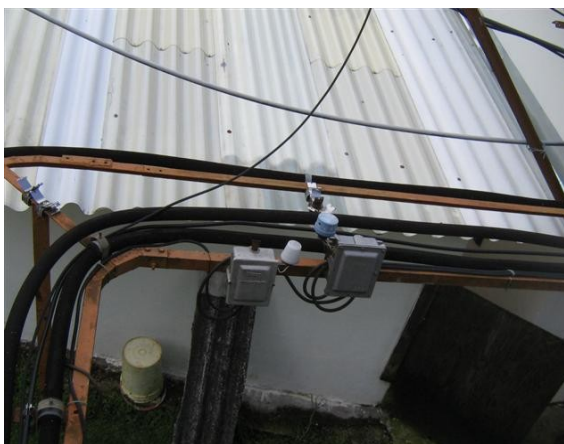
Escalerilla horizontal entrada salón de equipos
