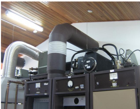
Ducto de refrigeración cadena uno - señal Colombia
