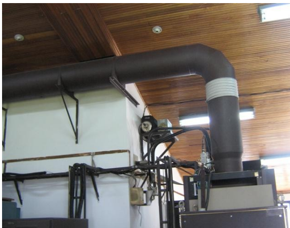
Ducto de refrigeración Señal Institucional
