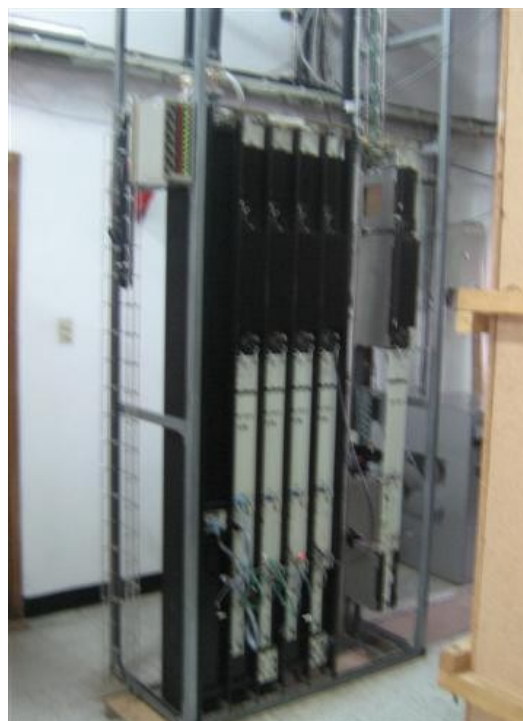
Sistema microondas Alcatel
