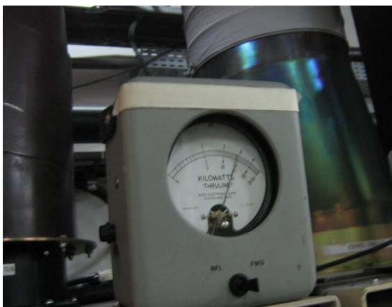
Medida de potencia directa con negro Tx C- 1 Principal
