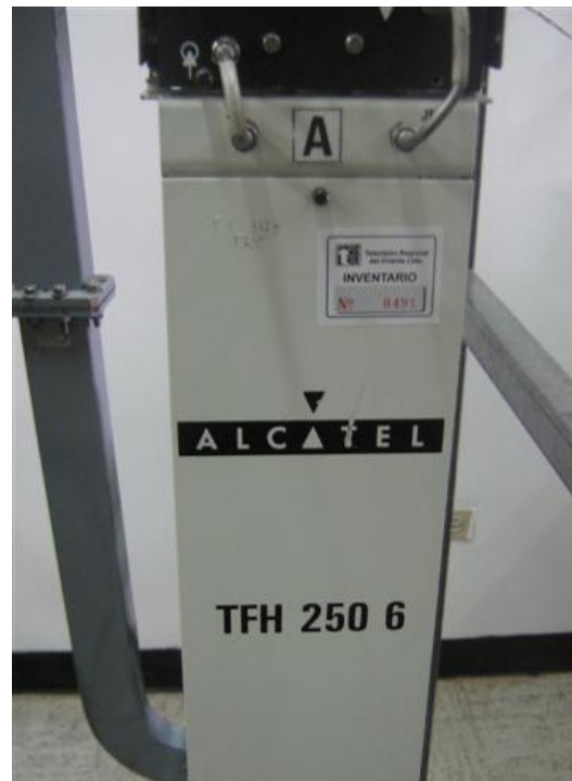
Radio Microondas
