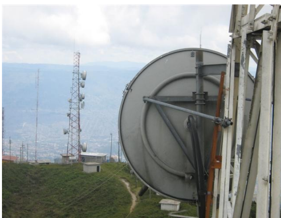
A 32.5m- V2-Antena microondas
