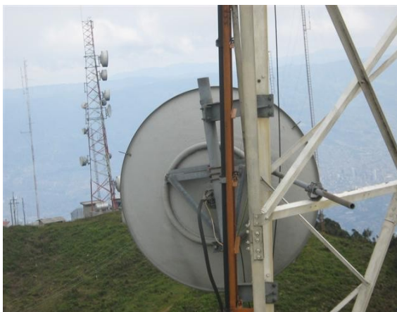
A 24m- V2-Antena microondas
