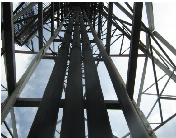
Cables bandeja superior torre
