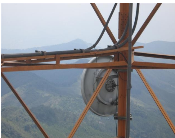
Antena microondas V-3 a 14 Mts
