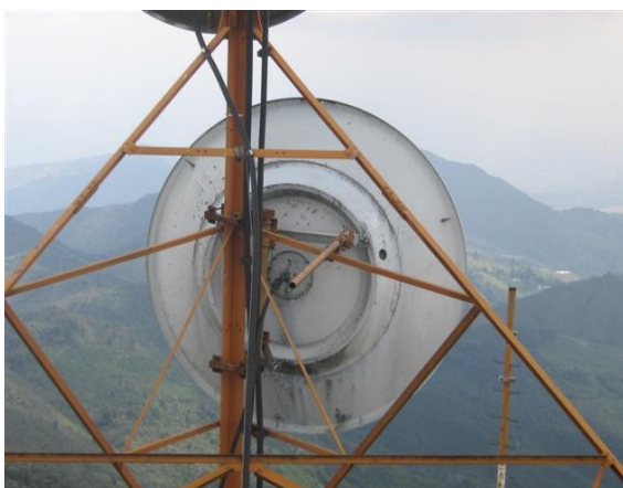
A 19m, V3. Antena microondas.
