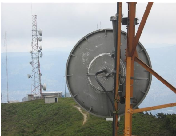
A 19m. V-2-Antena microondas
