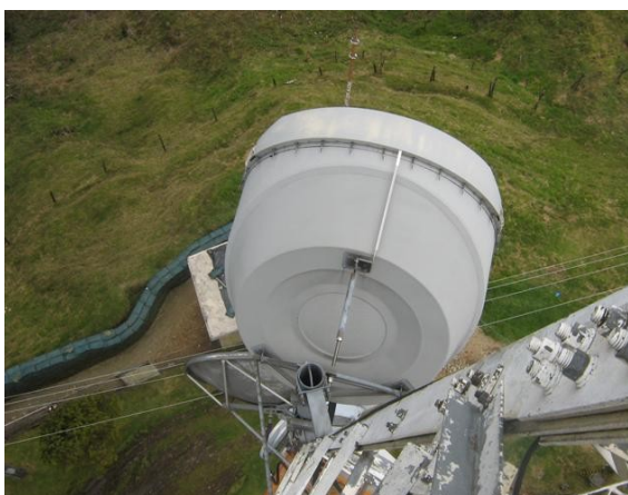
A 28m-V-3- Antena microondas
