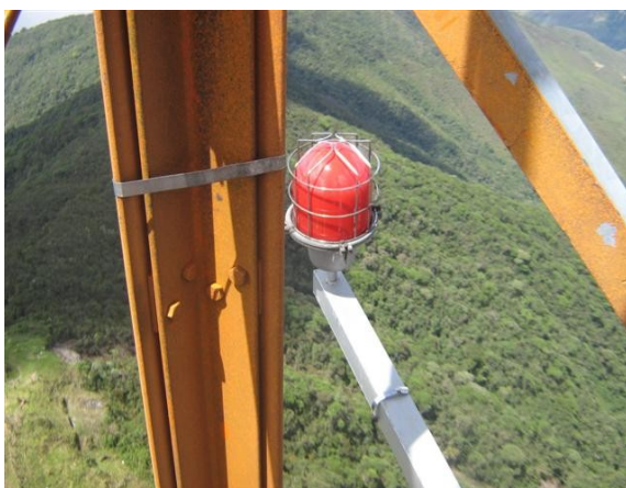
Luz de obstrucción a 99m en el vértice 1
