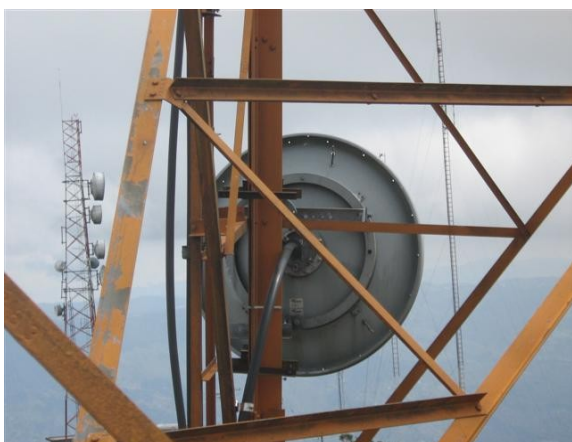
A 14m, V-2-Antena de microondas.
