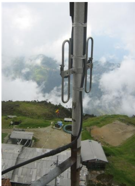
Antena a 32,5m en el vértice 1. Radio Motorola
