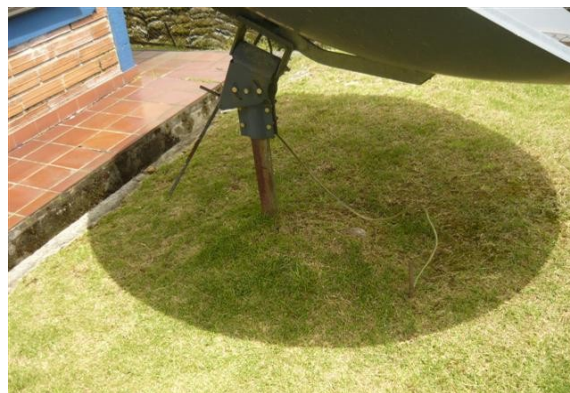
Puesta a tierra antenna satelital
