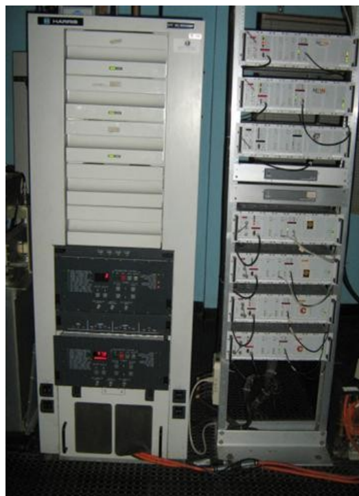
Tx Harris ppal y rack de offset C - 1
