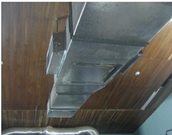
Ducto de aire acondicionado salón de equipos
