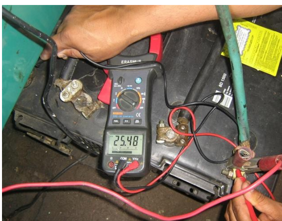
Medición Baterías planta Cumins
