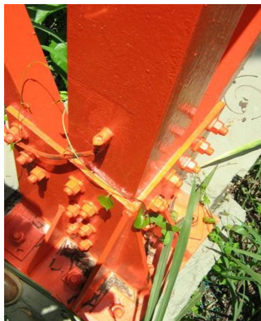
Pintura y tornillos de torre 2
