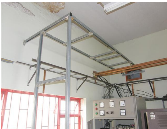
escalerillas salón equipos 1
