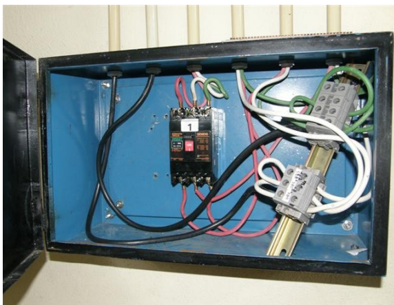
Breacker salón de equipos Harris
