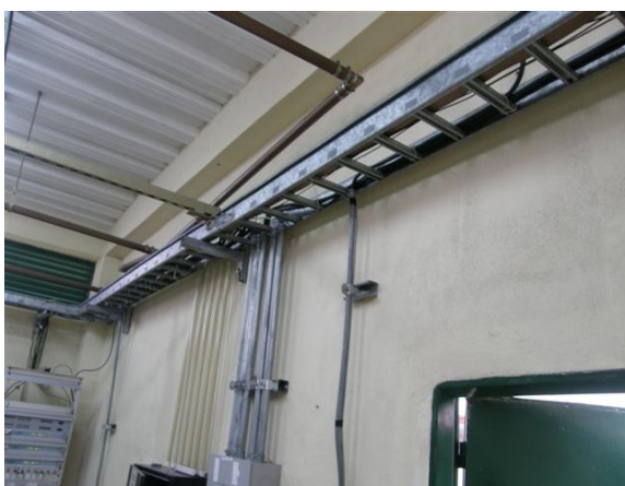
escalerilla en salón de equipos 1 (equipos Harris)
