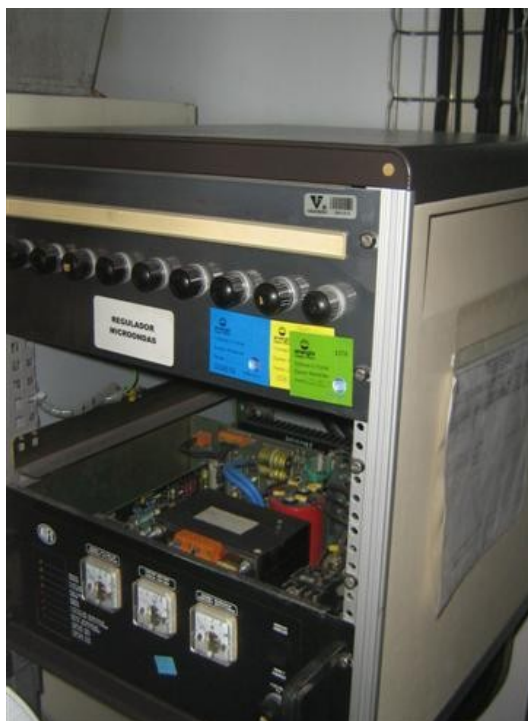
Regulador Cargador sin Módulo
