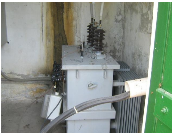
Filtraciones Salón transformador
