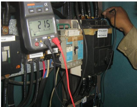
Medición de Volt T' - N
