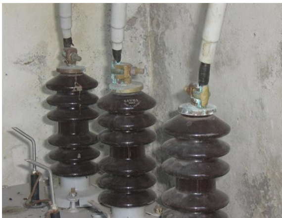
bornes AZULFATADOS de transformador Ppal Estación
