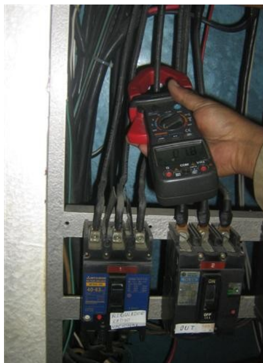
Medición Fase T TX Radionica
