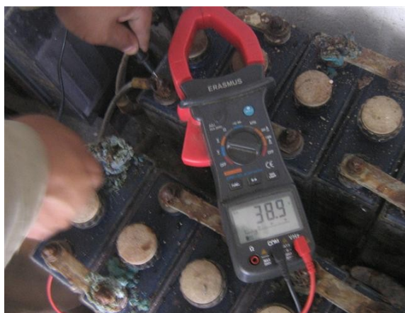
Medición de Volt banco de Baterías La popa
