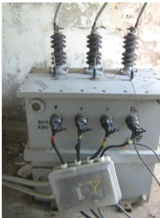
transformador de Estación.
