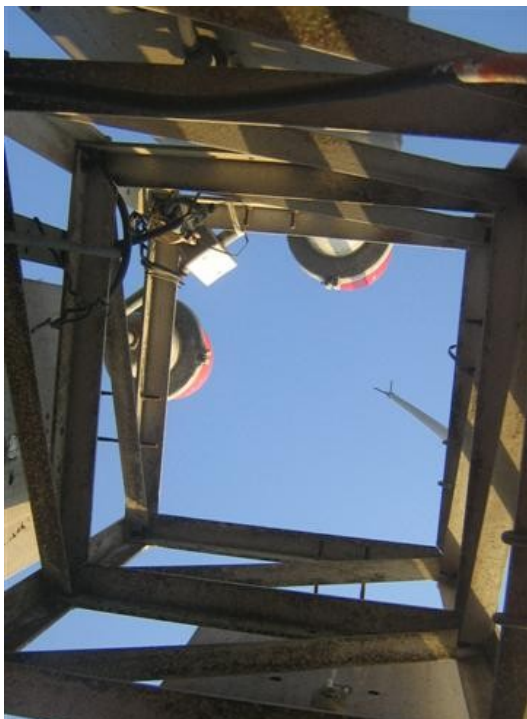
Detalles pararrayos y luces de obstrucción torre
