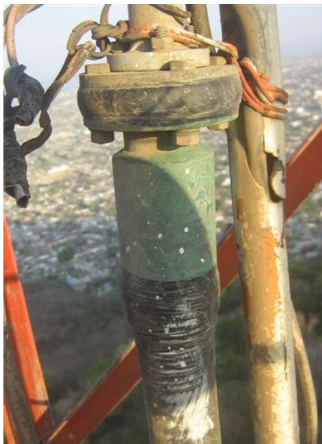
acople línea de TX R.T.V.C
