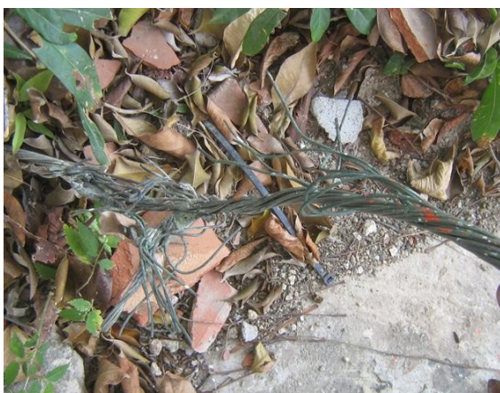
cable malla de tierra torre en mal estado
