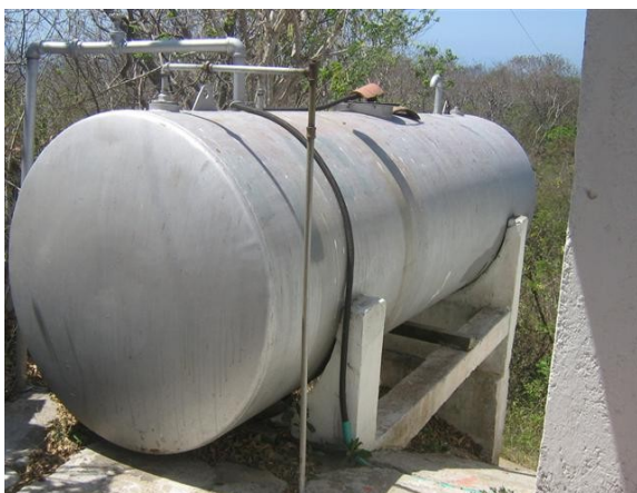
tanque de almacenamiento A.C.P.M 2,100g
