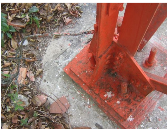
cable de tierra en mal estado
