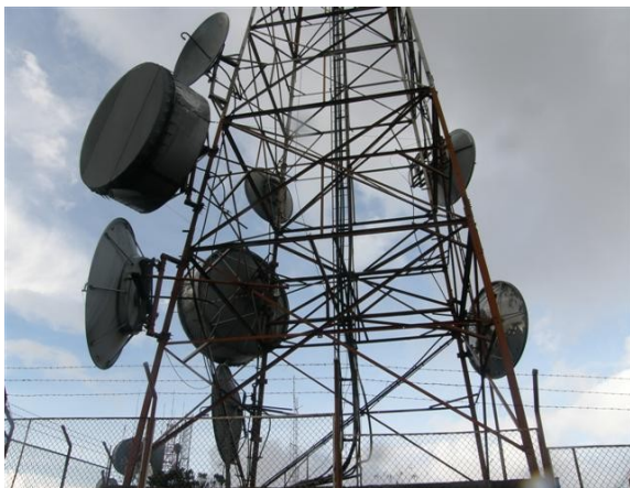
Antenas microondas
