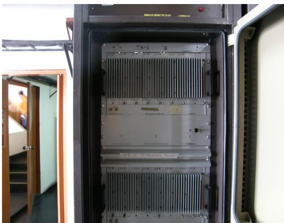
transmisor reserva canal uno no indica potencia de salida en carga artificial
