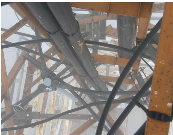
Estado pintura y líneas de transmisión
