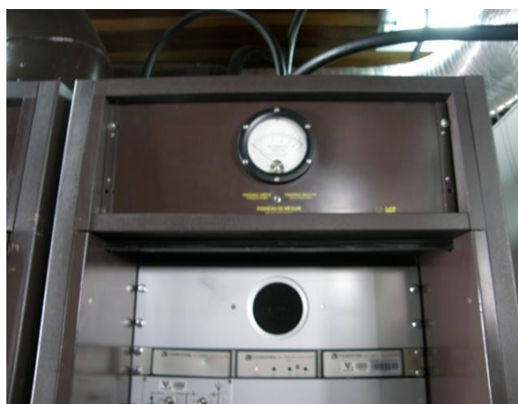
Vatimetro en canal institucional no funciona por falta de diodo
