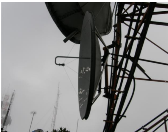
Antena microondas
