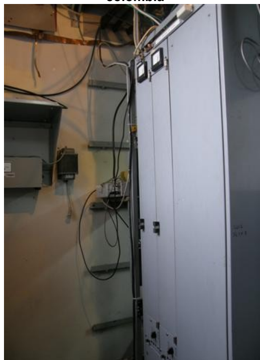
Demoduladores de microondas telefonos 40 años de servicio
