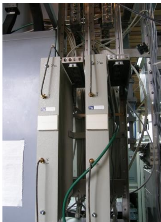
microondas seel en salón de equipos
