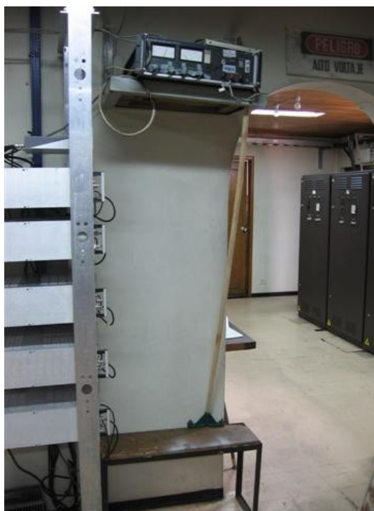
Detalle escoba sostiene fuente
