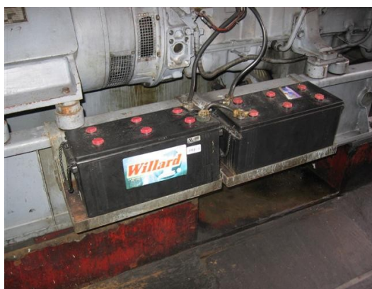
Baterías planta No. 2
