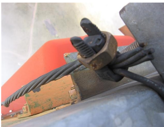
Detalle conexión pararrayos
