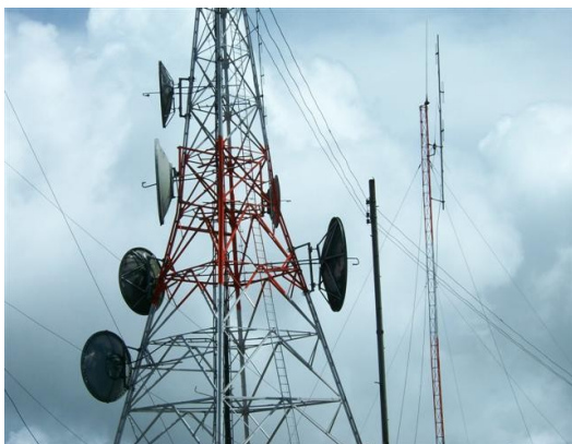
Detalle dirección Parabólicas de MW
