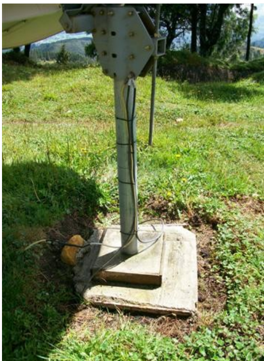
Base y conexión de tierra de parabólica
