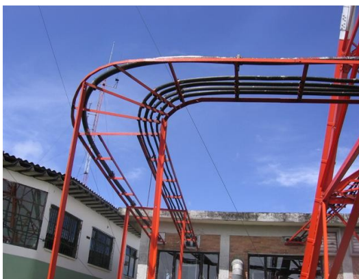
Escalerillas de MW alcatel y Tx. SC
