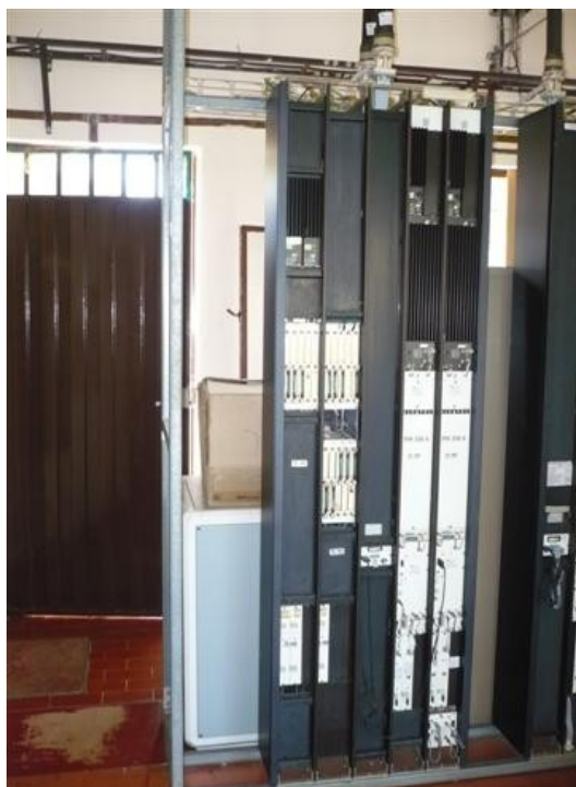
Radios Microondas TRO
