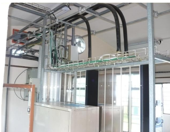
Escalerillas microondas
