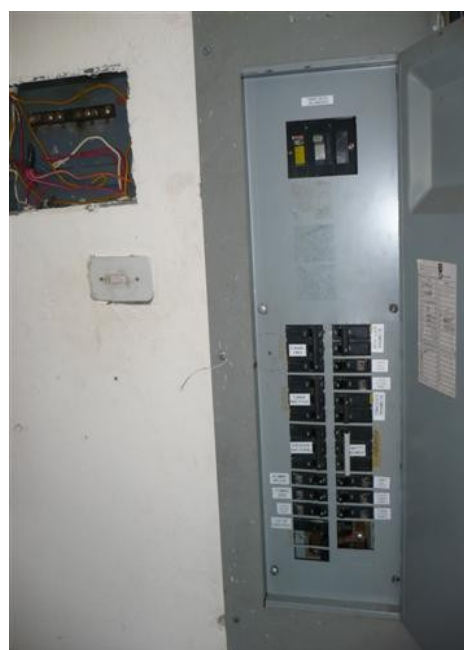
Caja de breakers salón de equipos
