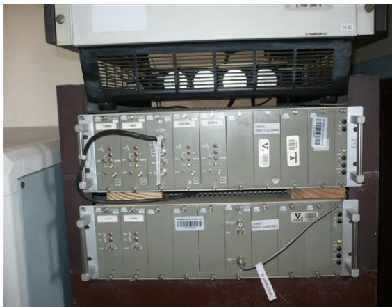
Modem Microondas
