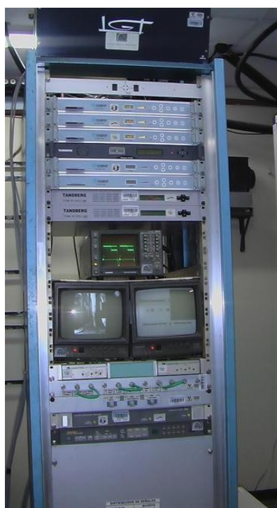
Panel de Control - Receptores Satelitales
