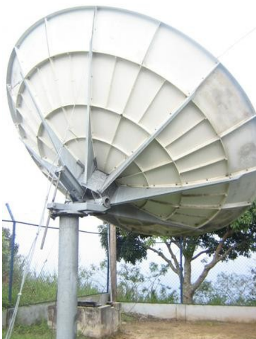
Antena parabólica Banda C (1)
