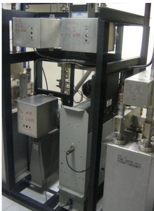
Cadena de filtros transmisor Harris
