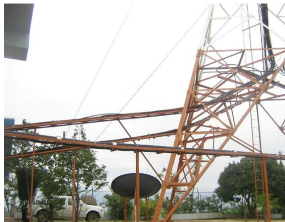
Escalerillas hacia el salón de equipos
