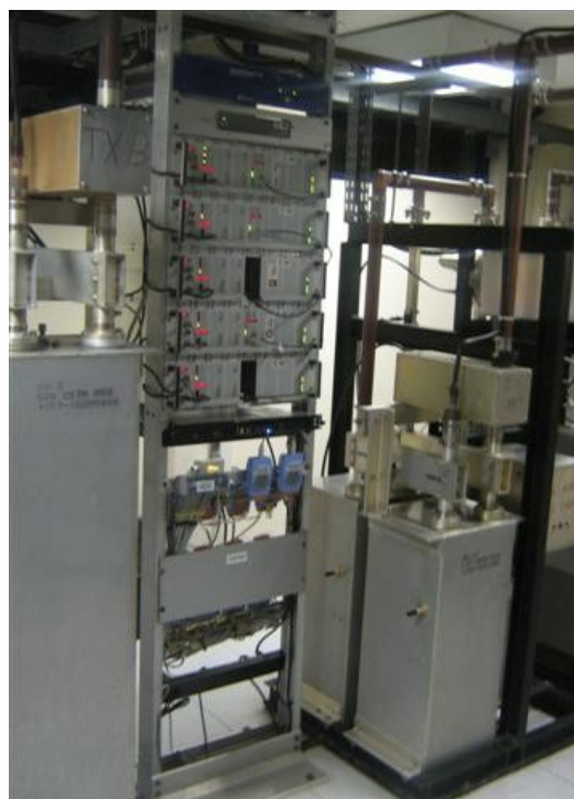
Rack de offset de precisión
