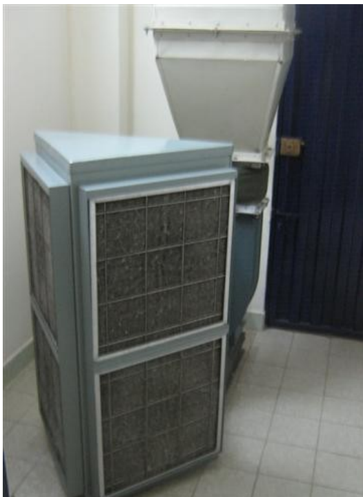
Filtros sistema de ventilación 3
