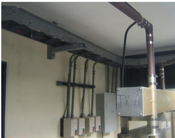
Escalerilla y linea de transmisión 2
