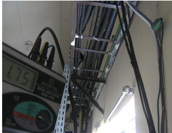
Sistema de Puesta a tierra Planta 6
