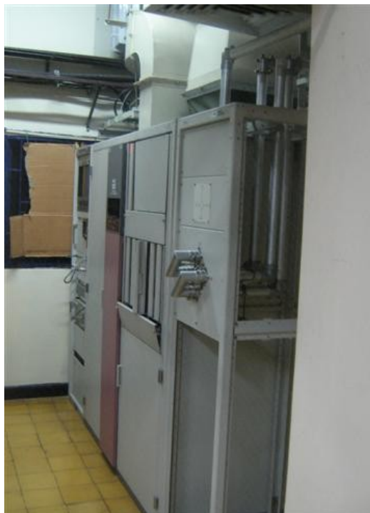
Transmisor principal NEC señal Colombia
