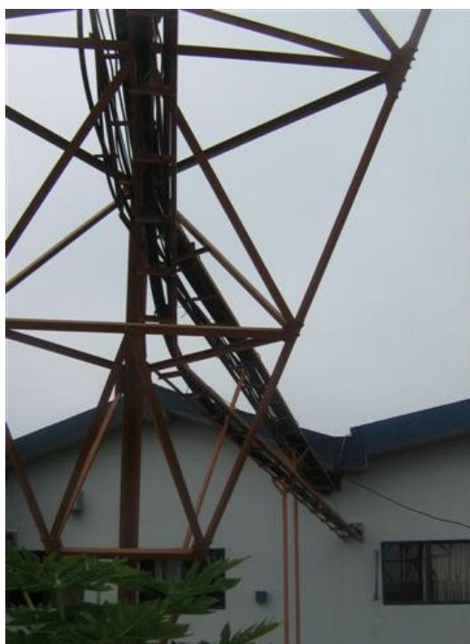
Escalerilla hacia el salón de equipos
