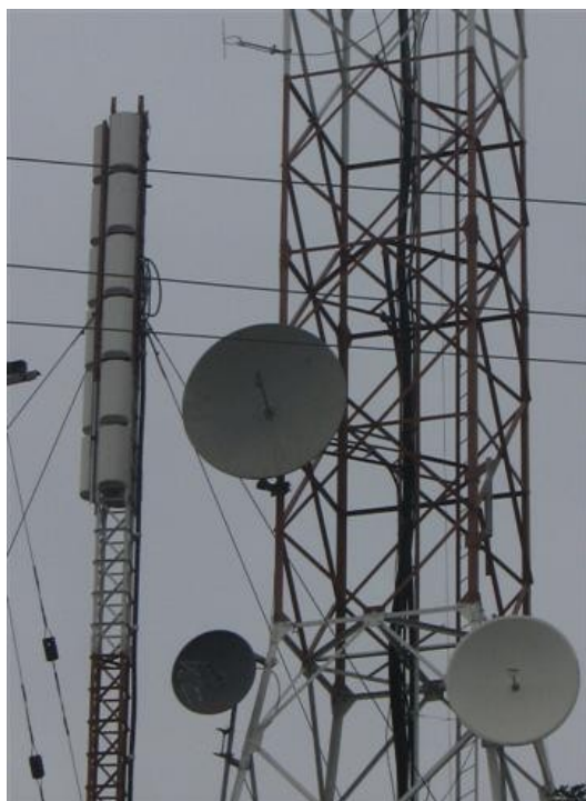
Antenas uW torre 1 y panel UHF torre 2
