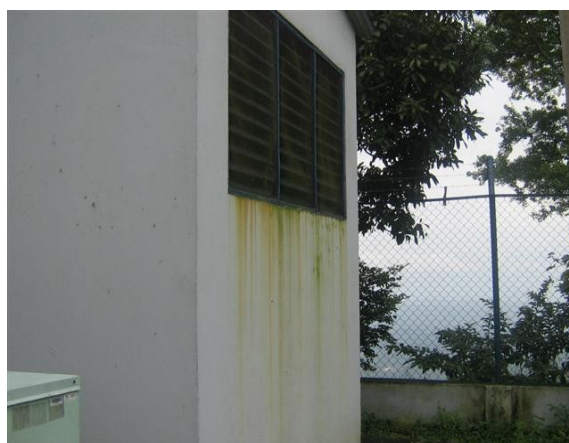
Humedad en paredes
