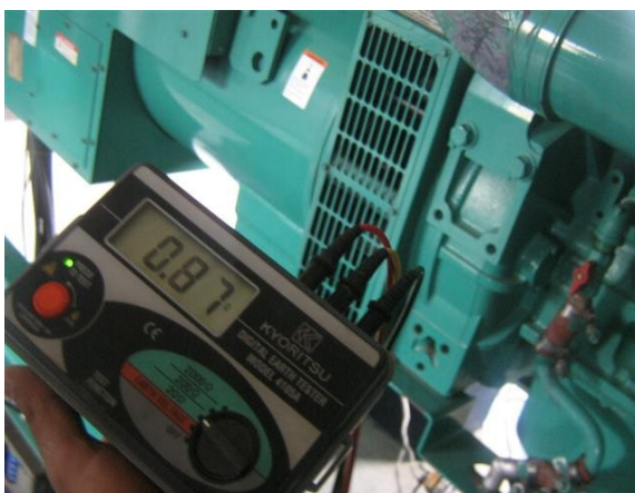
Sistema de Puesta a tierra Planta 2
