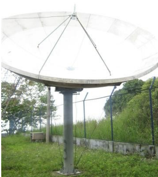
Antena parabólica Banda C (3)
