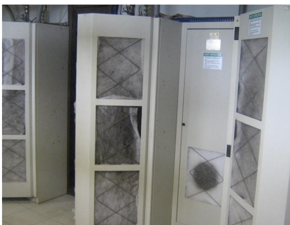
Filtros sistema de ventilación 1
