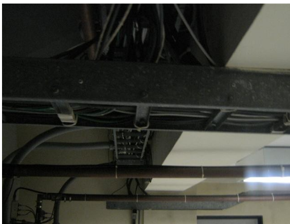
Escalerilla y lineas de transmisión
