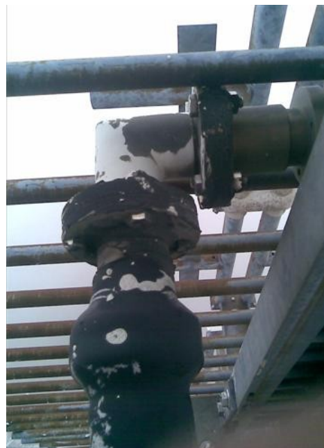
Detalle conector y corrosión en paneles
