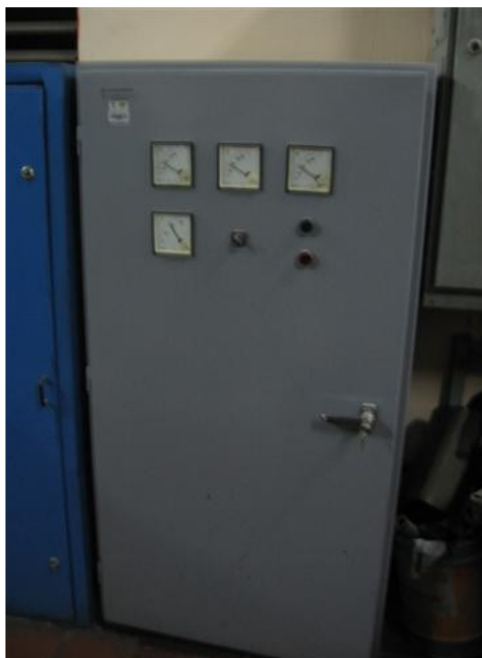
Transferencia Automática FS
