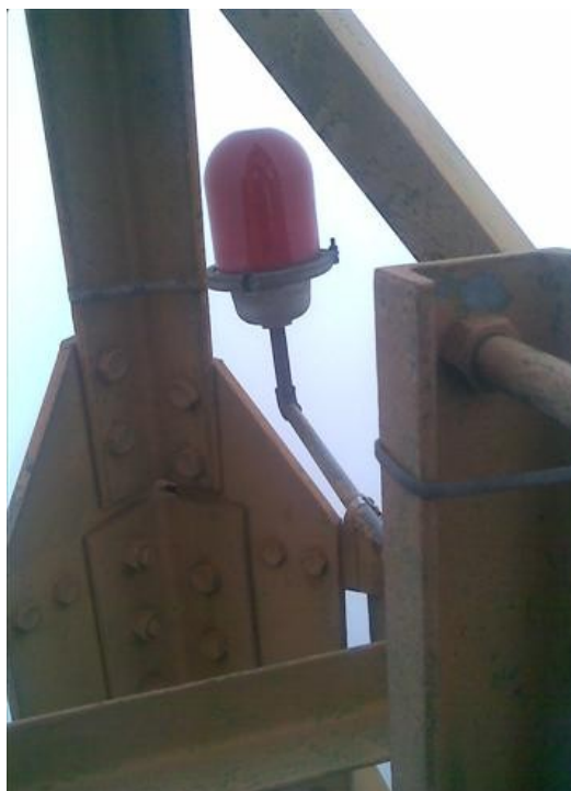
Detalle corrosión paneles
