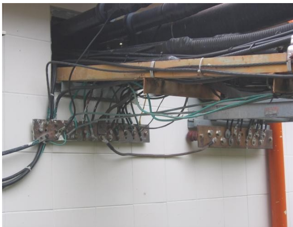
Otras platinas para aterrizas coaxiales y guías de onda
