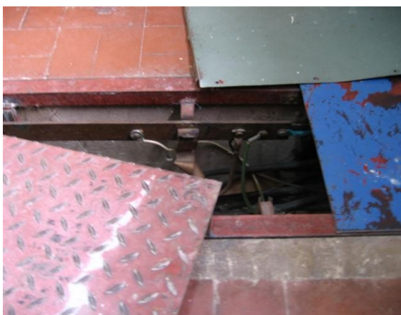
Platina de tierra del Salón de Equipos
