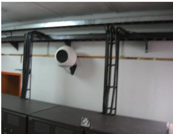
Escalerillas salón de equipos
