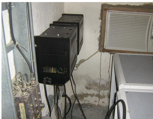
Acondicionadores de línea estación
