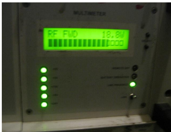
Medición de potencia Señal Colombia
