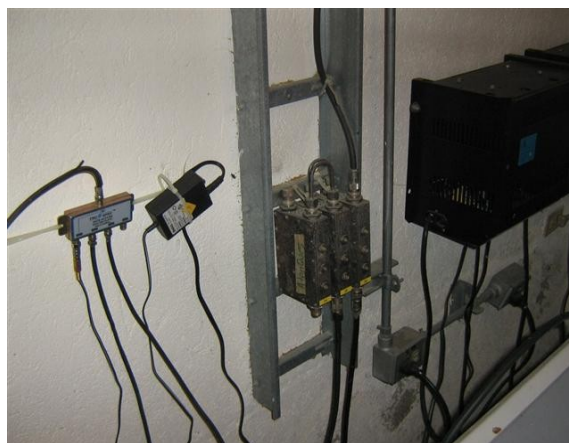
Triplexor sistema radiante
