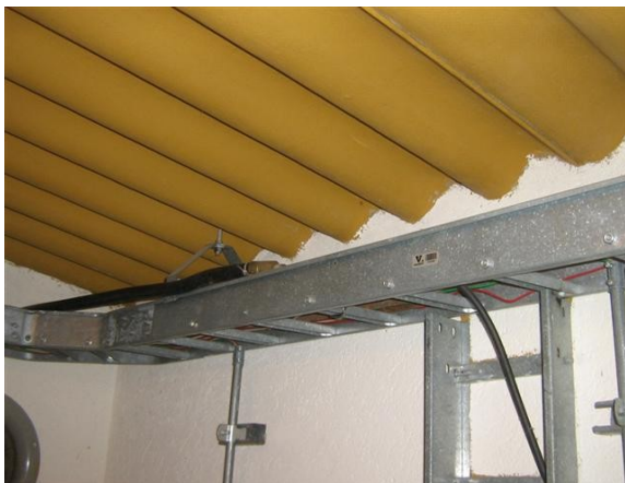
Techo - escalerilla salón de equipos
