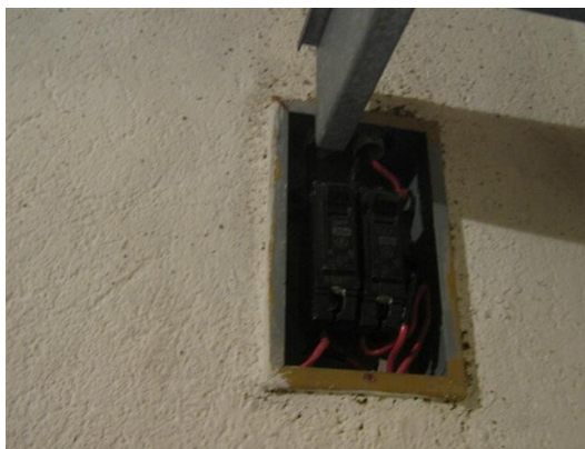
Caja Principal de breacker salón de equipos
