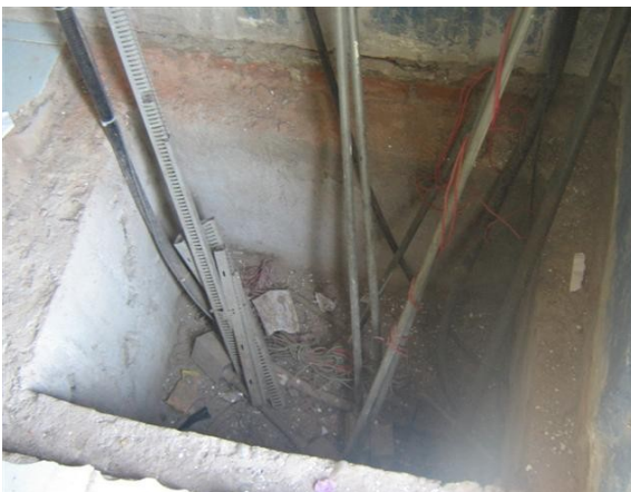
Salida de líneas de Tx a Salón de Equipos
