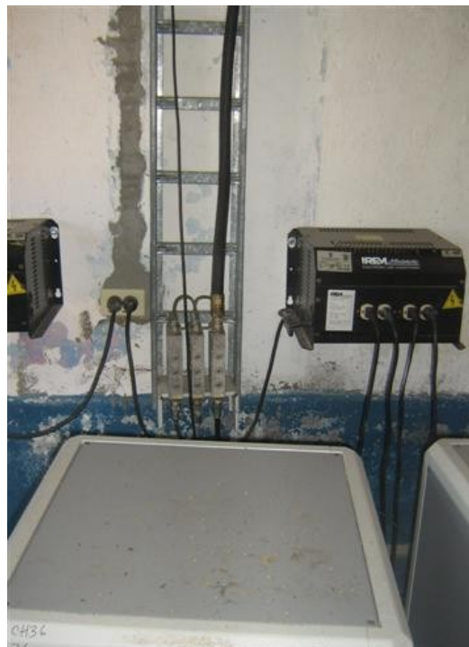
Triplexor sistema radiante
