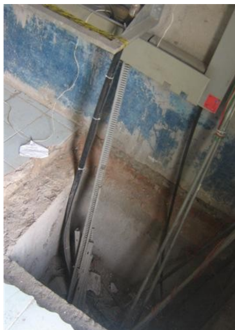
Cámara ingreso de cables Salón de equipos
