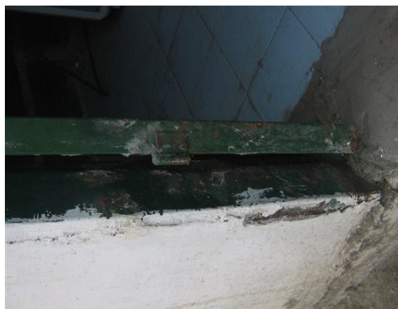
Bisagra puerta Principal en mal Estado
