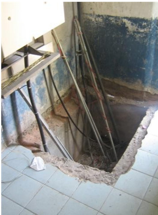
Cámara ingreso de líneas de Tx a Salón de equipos
