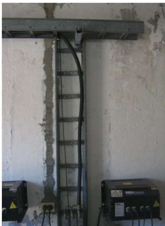
Escalerilla vertical Salón de equipos
